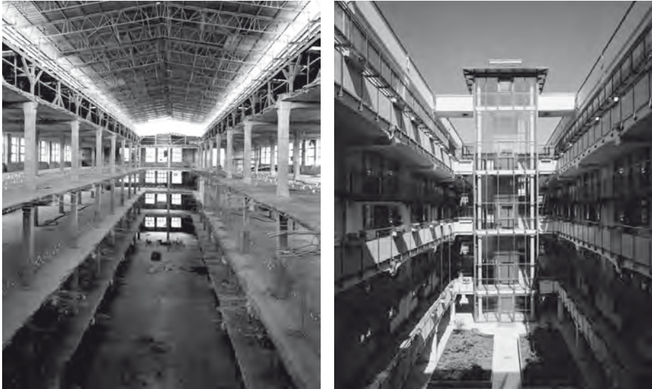
Abb. 2, 3: Buntgarnwerke: links: Hochbau Süd nach dem Einschnitt; © Fuchshuber Architekten ; rechts: Hochbau Süd nach der Konversion; © Hans-Christian Schink .
