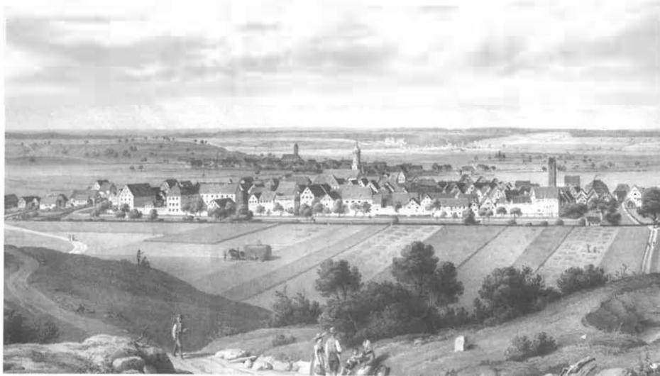
Abb. 1: Stadtsicht von Südosten vom Missionsberg 1840 (Lithographie: E. Emminger); im Westen noch deutlich der Wall, der um die Stadt Mauer und Graben nach außen abschirmte sowie die großteils intakte Stadtmauer; im Osten die untere Vorstadt, nach dem Brand von 1819 gebaut; im Hintergrund links der Ennetacher Berg, noch fast baumlos.
