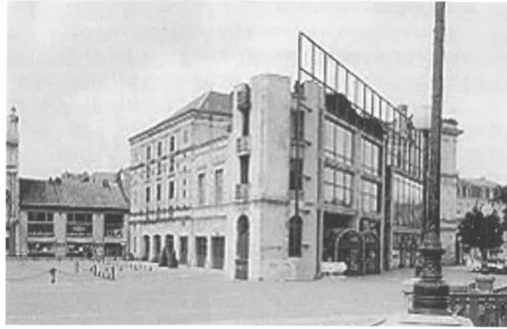
Abb. 4: Gewolltes Chaos. Umbau der Veranstaltungsräume und des Theaters von Belfort; Architekt: Bernard Sauterau, 1991.
