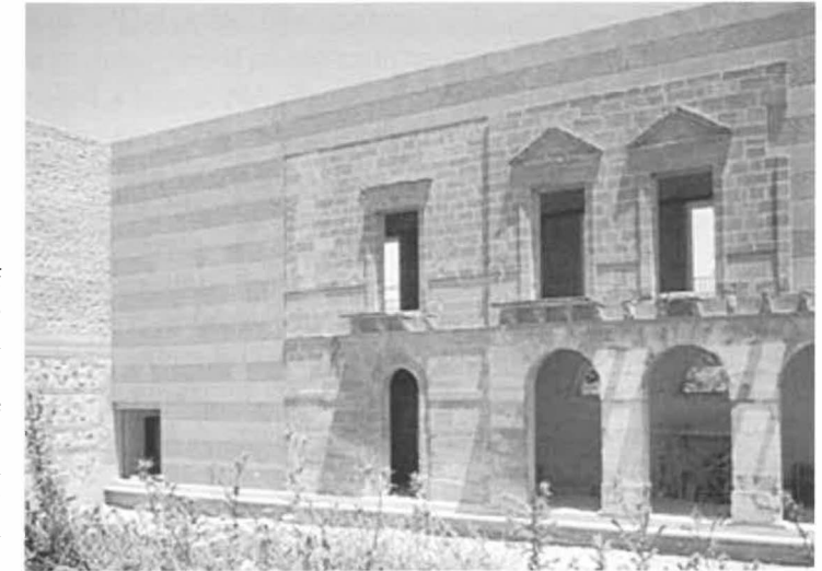
Abb. 3: Innenhof des neuen Museo Civico von Gibellina. Zwei deutliche Fugen betonen den fragmentarischen Charakter der eingefügten alten Fassade.
