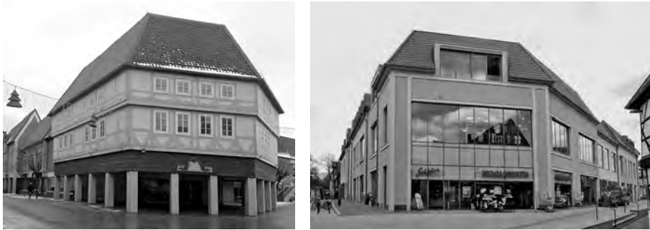
Abb. 3a, 3b: Ehemaliges Hertie-Warenhaus in Wolfenbüttel vor dem Abriss (li.) und nach dem Neubau (re.); Fotos: N. Hangebruch, landus.
