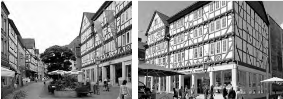
Abb. 2a, 2b: Ehemaliges Hertie-Warenhaus in Eschwege vor (li.) und nach dem Umbau. (re.) Fotos: W. Conrad, E. Bennighof.
