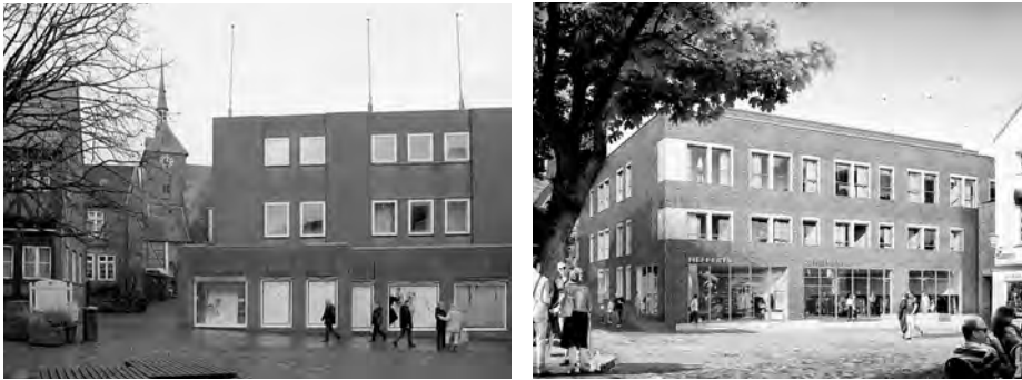
Abb. 5a, 5b: Ehemaliges Hertie-Warenhaus in Rendsburg vor (li.) und nach dem Umbau (re.). Fotos: Architekturbüro Schaffer.
