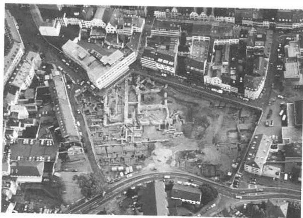
Abb. 3: Der Viehmarkt in Trier, Luftbild nach Sicherung der Baugrube und abgeschlossene Grabungen; die Fundamente der Thermenanlage treten deutlich hervor.
