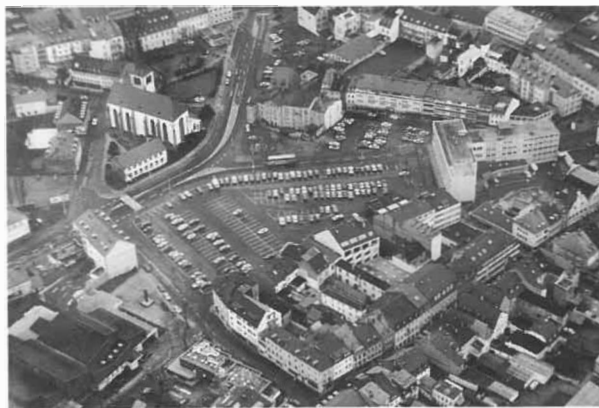
Abb. 2: Der Viehmarkt in Trier, Luftbild vor Beginn der Abbruch-Arbeiten.
