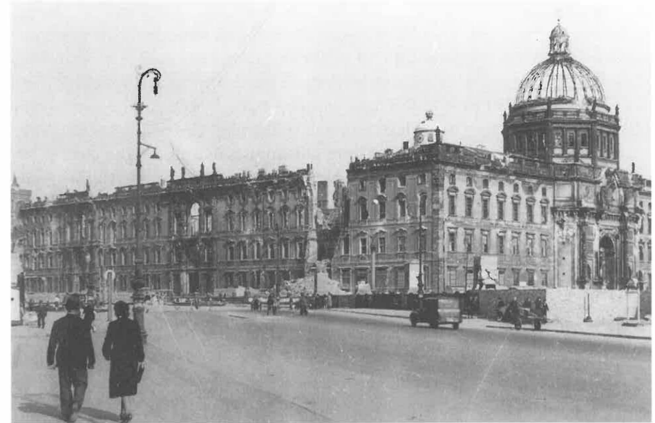
Abb. 2: Das Berliner Stadtschloß als Ruine kurz vor seiner Sprengung. Diese Aufnahme dokumentiert sehr deutlich den Grad der Zerstörung.
