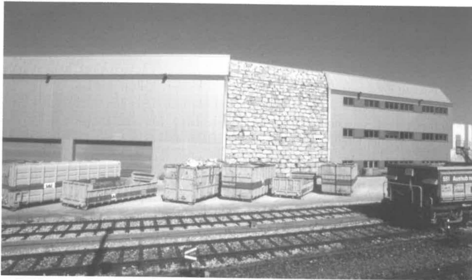
Abb. 1: Lagerhaus in Zürich mit Eidechsenweg.
