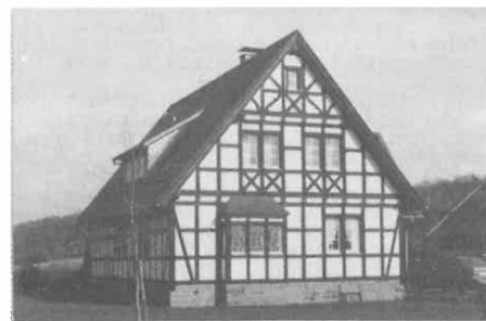
Abb. 10.7 Neubau in Fachwerkbauweise in Schwerfen
