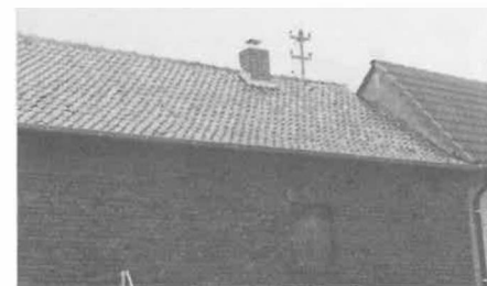
Abb. 10.8 Links: Eindeckung mit »Schwerfener Ziegel«
