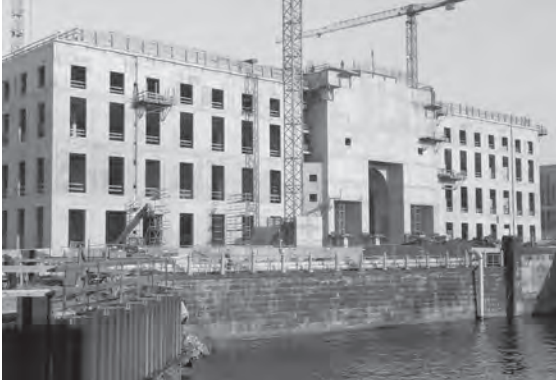
Abb. 7: Baustelle des Humboldtforums, 2012; Foto: H. Bodenschatz.
