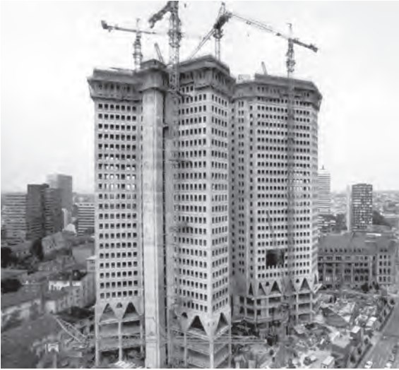
Abb. 7: Lochfassaden der im Bau befindlichen Türme der Deutschen Bank Zentrale 1982; Quelle: Deutsche Bank AG, Historisches Institut.
