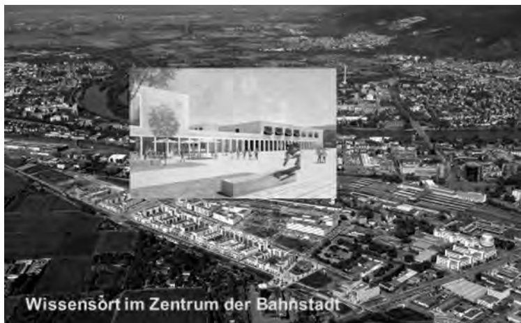
Abb. 3: Neubau des Bildungs-, Betreuungs- und Bürgerhauses B 3 in der Bahnstadt; Luftbild: Kai Sommer; Grafik 1: Preisträger Realisierungswettbewerb Peter Donn Datscha Architekten / KUULA Landschaftsarchitekten
