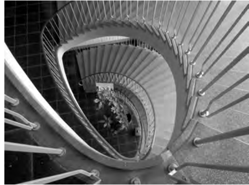
Abb. 5: Treppenhaus des Erich-Rammler-Baus; Foto: R. Bruha.
