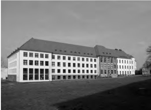
Abb. 4: Fassade des Erich-Rammler-Baus; Foto: R. Bruha.
