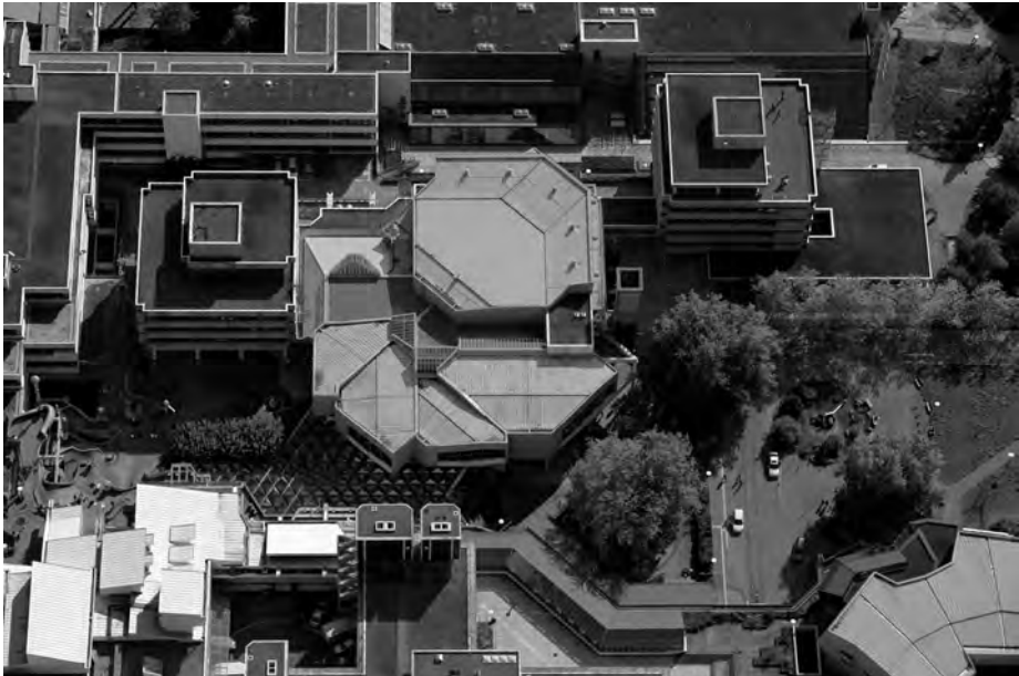
Abb. 2: Luftbild der Zentralen Einrichtungen der Universität Konstanz aus nördlicher Richtung: Forum mit Mensa (links unten), Institutsbauten mit Bibliothek (oben), Großes Hörsaalzentrum mit Audimax (Mitte), Busterminal und kleines Hörsaalzentrum (rechts); Foto: LAD BW Esslingen, O. Braasch 2009.
