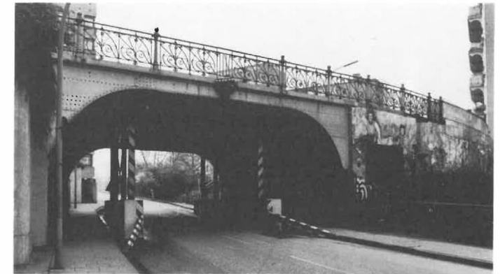
Abb. 8: Hochstraßenbrücke 1983 von Süden (Baubehörde Hamburg)
