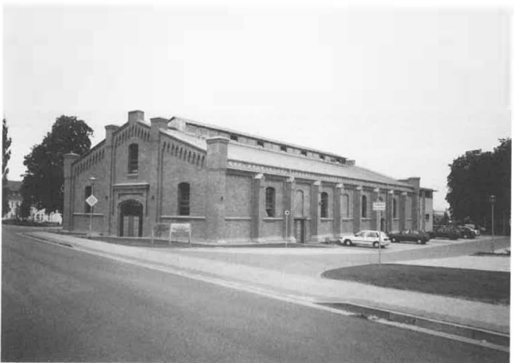
Abb. 3: Ehemalige Reithalle nach der Sanierung 2000 (heutige Stadt-halle).
