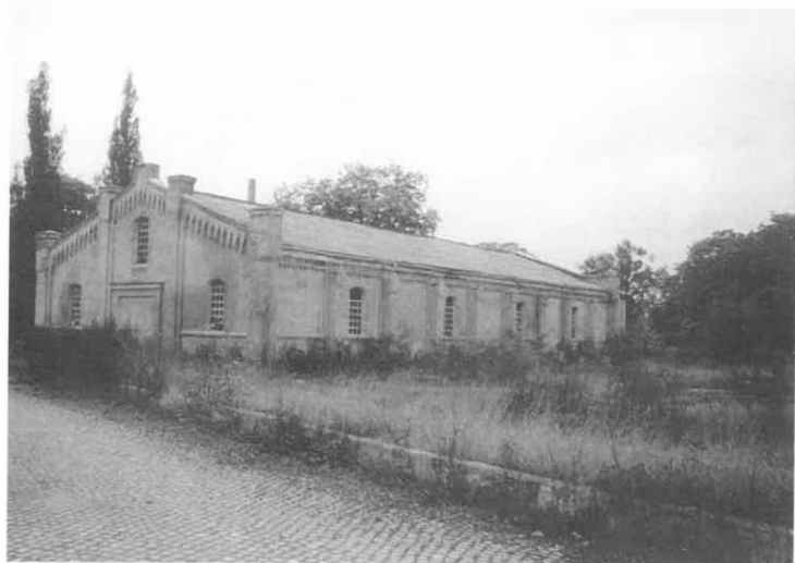
Abb. 2: Ehemalige Reithalle (Baujahr 1893/94) vor der Sanierung 1995.
