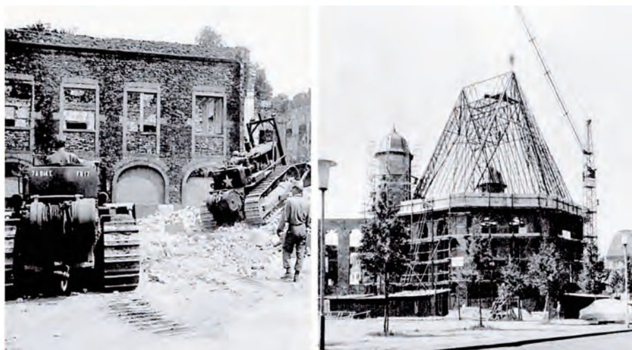
Abb. 8: (li.) Abrissarbeiten unter Mithilfe der US-Army am Friedrichsbau des Hanauer Stadtschlusses, 1955; Foto: A. Schröder.
