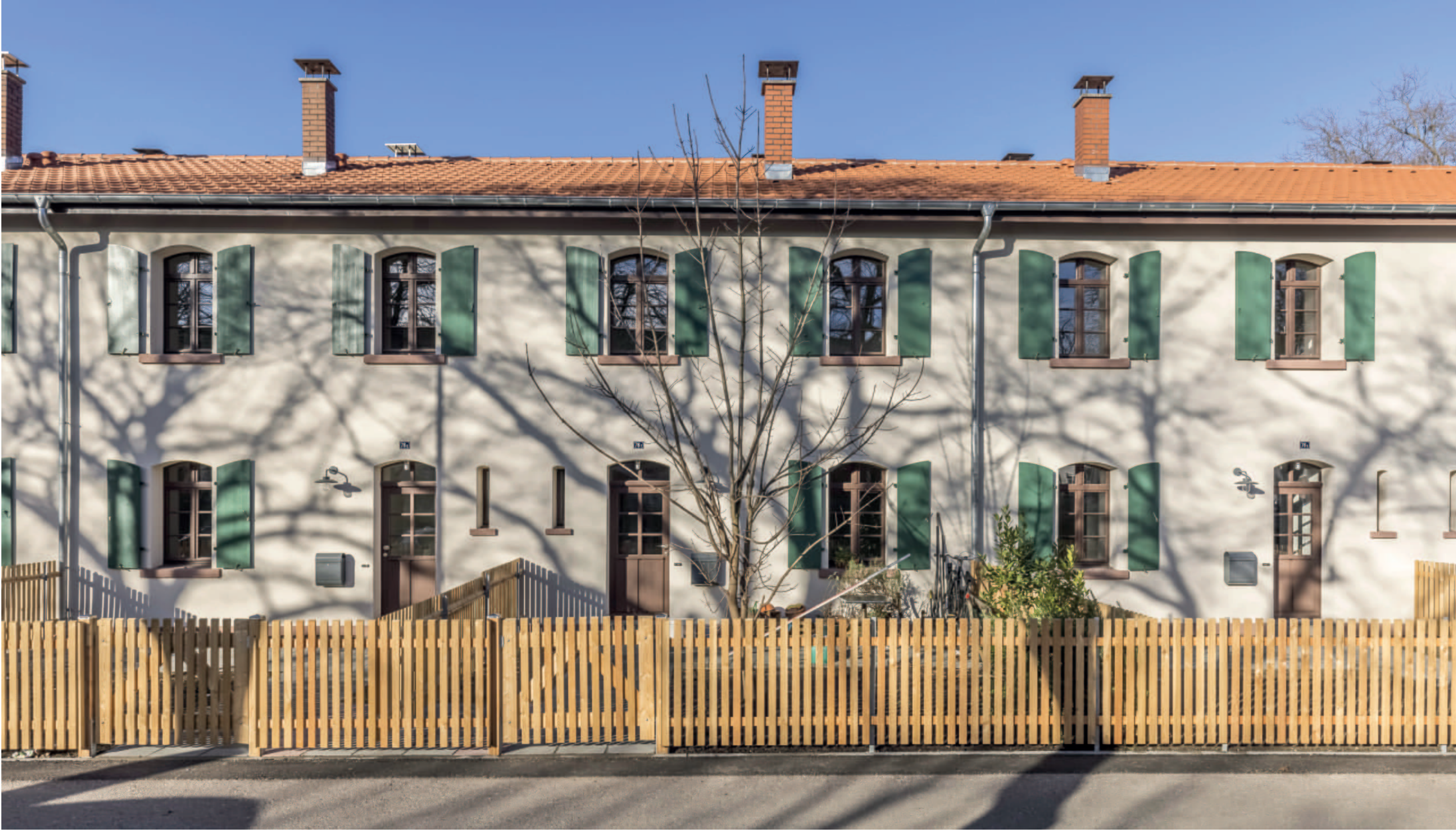
Doppelhauszeile nach Sanierung, Quelle: Spiegelhalter, FSI
