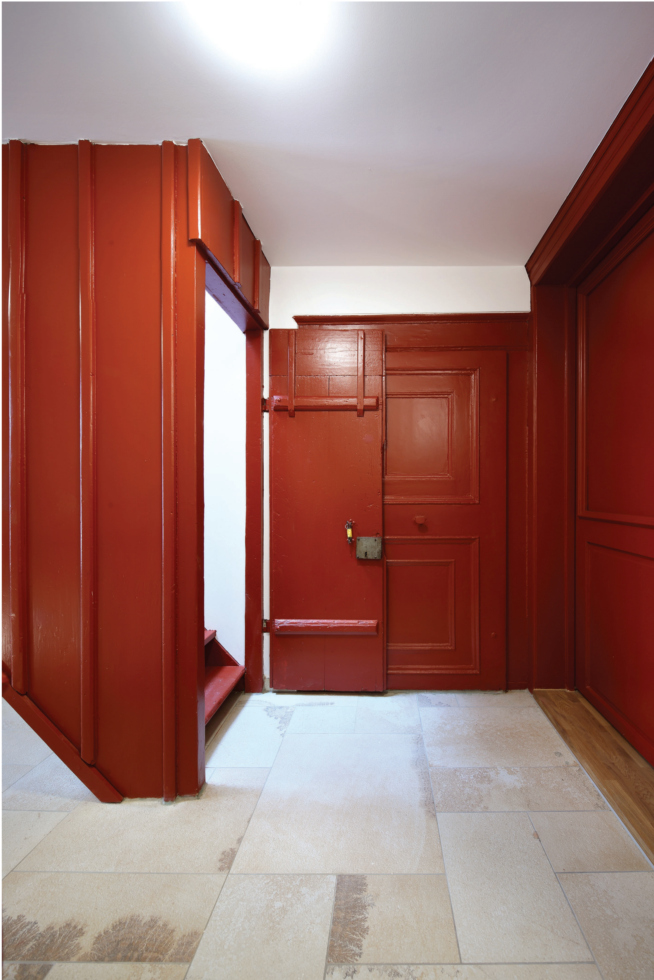
HISTORISCHER TREPPENEINBAU UND TÜREN AUS DEM 18. JAHRHUNDERT
