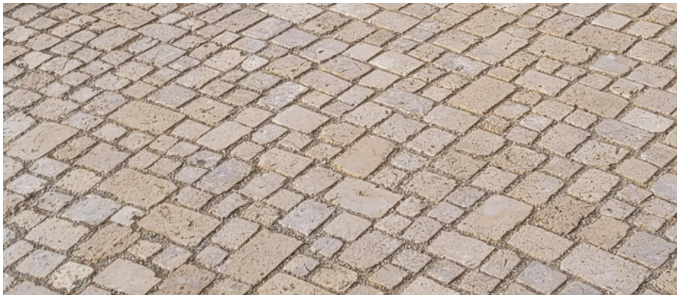
Diagonalwege aus Kleinsteinpflaster
