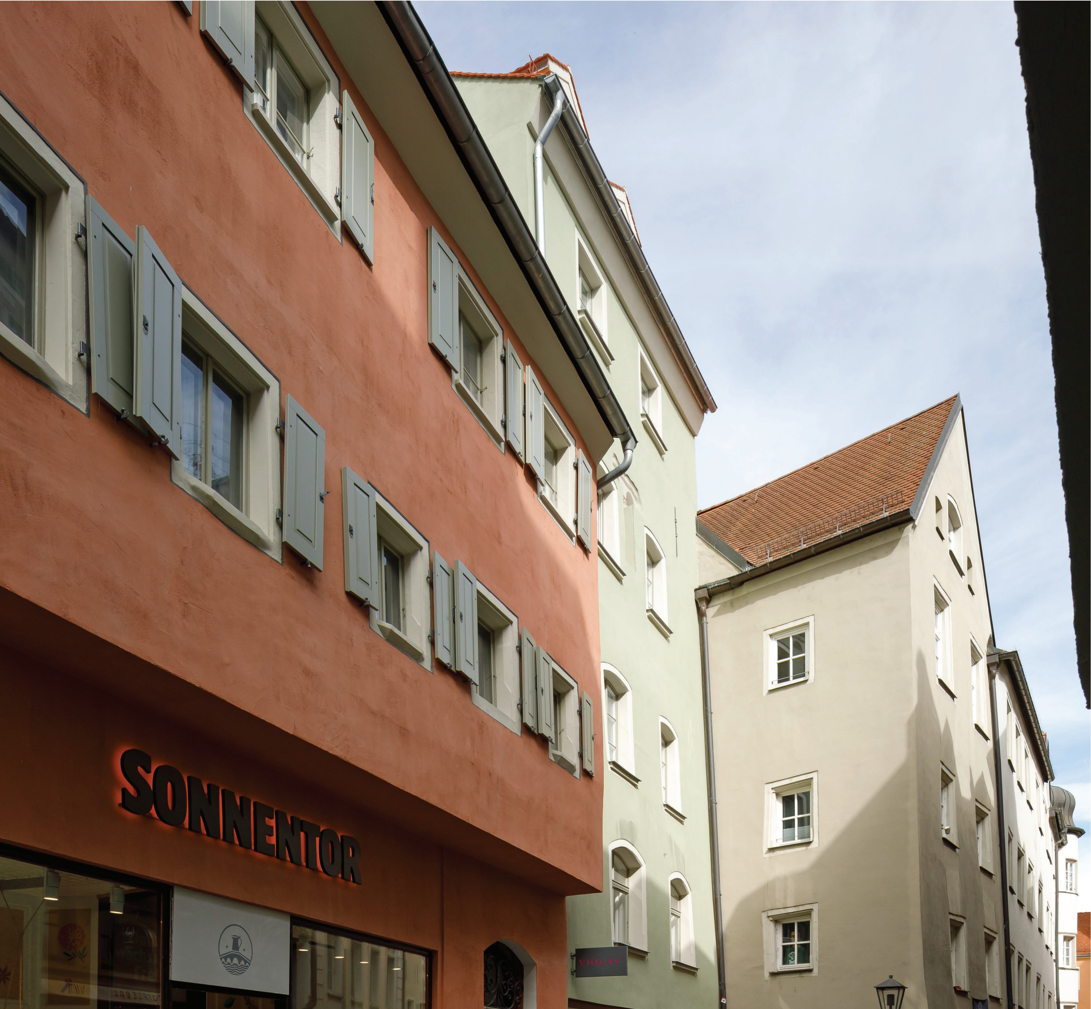
FASSADE BRÜCKSTRASSE 4 - „ROTES HAUS“ MIT ÜBERSTAND
