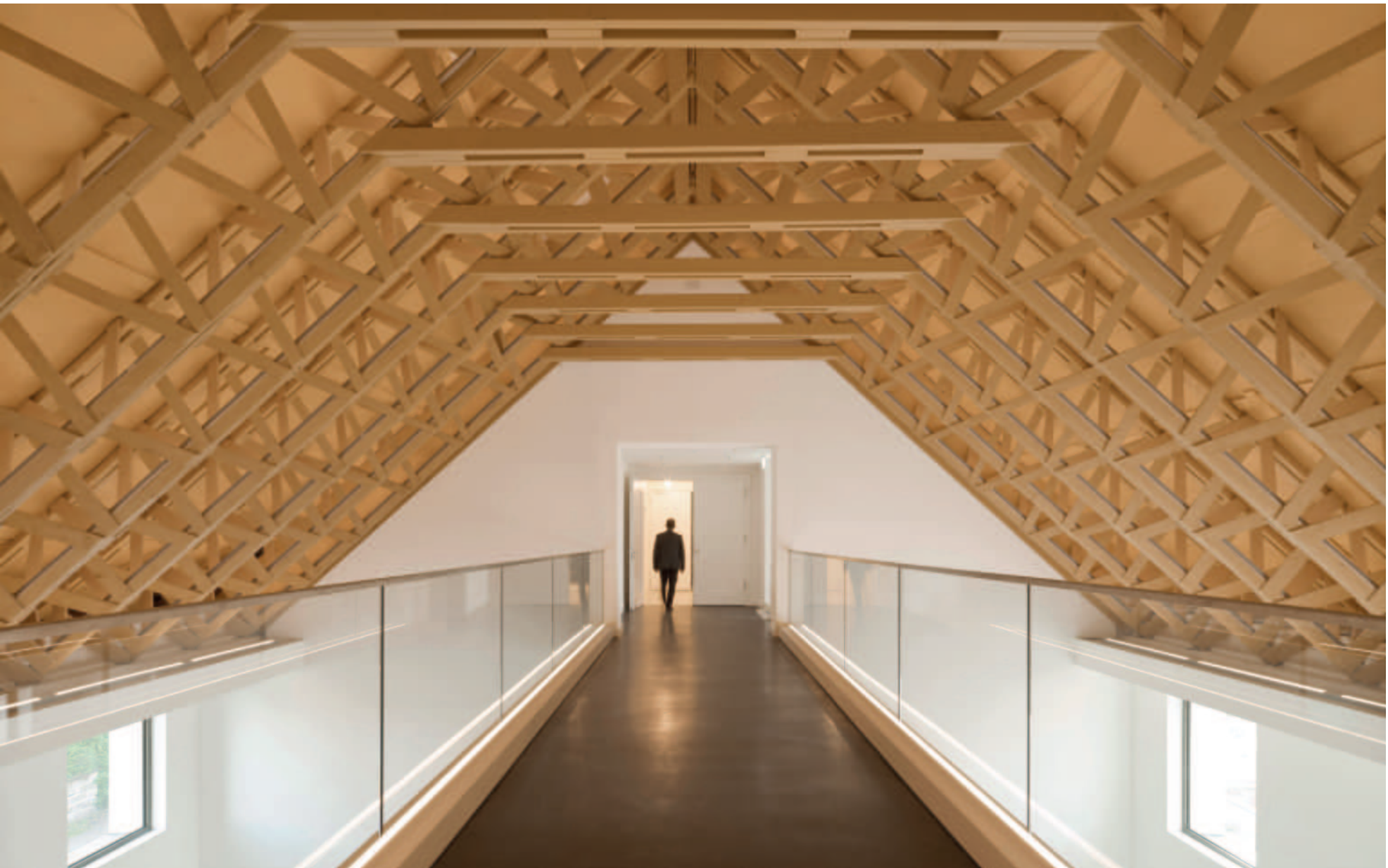
Die Dachkonstruktion aus Kroher-Bindern ist ein herausragendes Merkmal des denkmalgeschützten Hauses.
