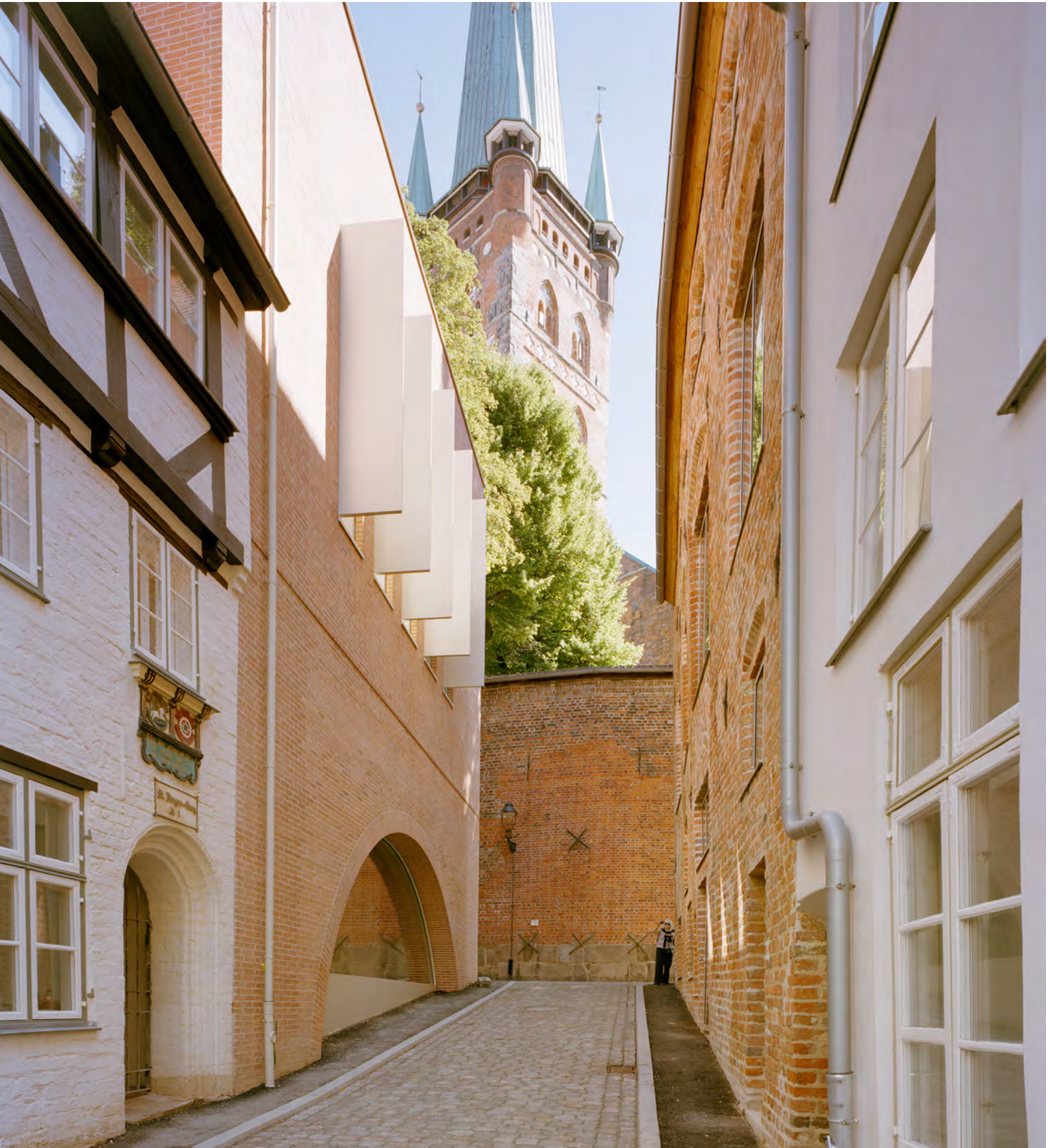
Kl. Petersgrube: Im Anschnitt die sanierten Kleinhäuser, links das Theater, rechts das Museum
