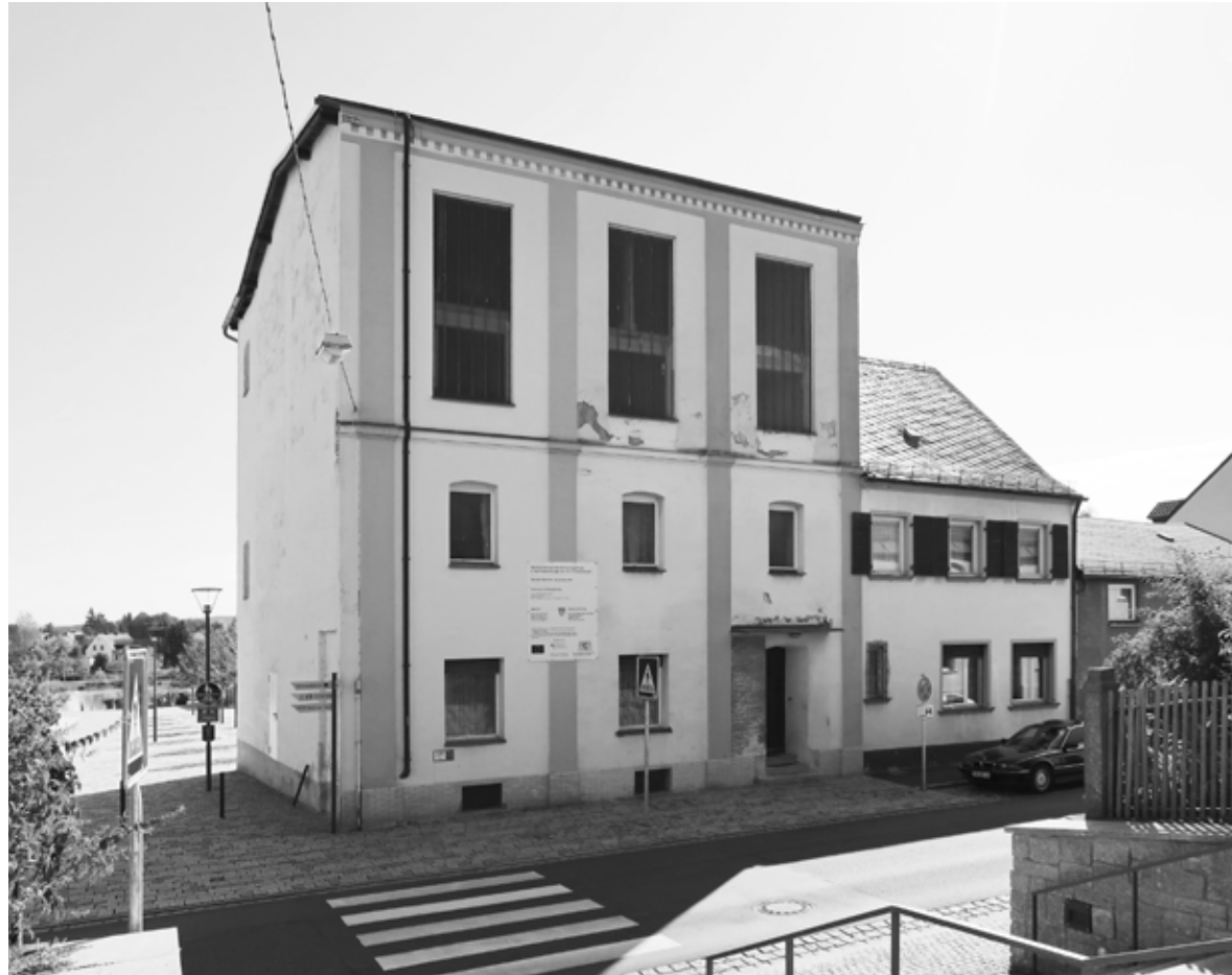
Bestandsgebäude der Brauerei Schels vor der Sanierung.
