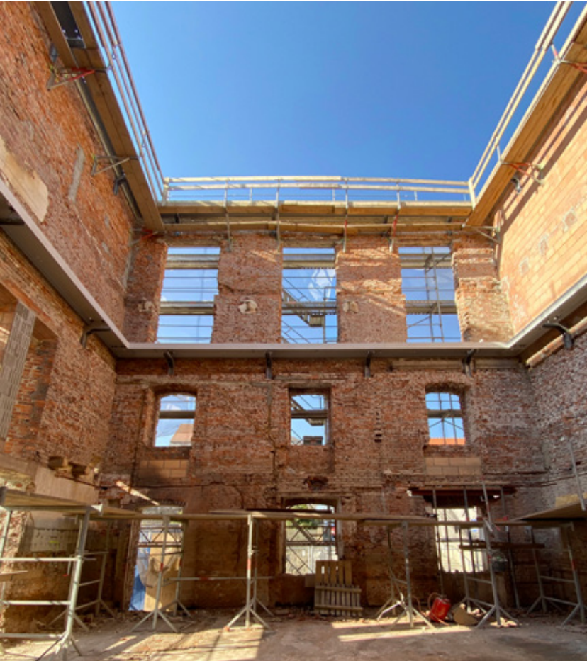
Baustelle: Das Gebäude wurde komplett entkernt.
