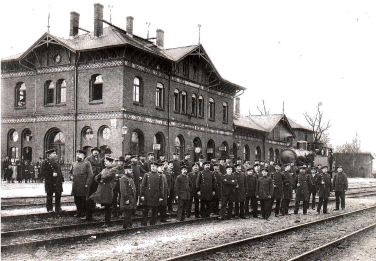
Historisches Foto Nordostansicht mit Personal 1913
