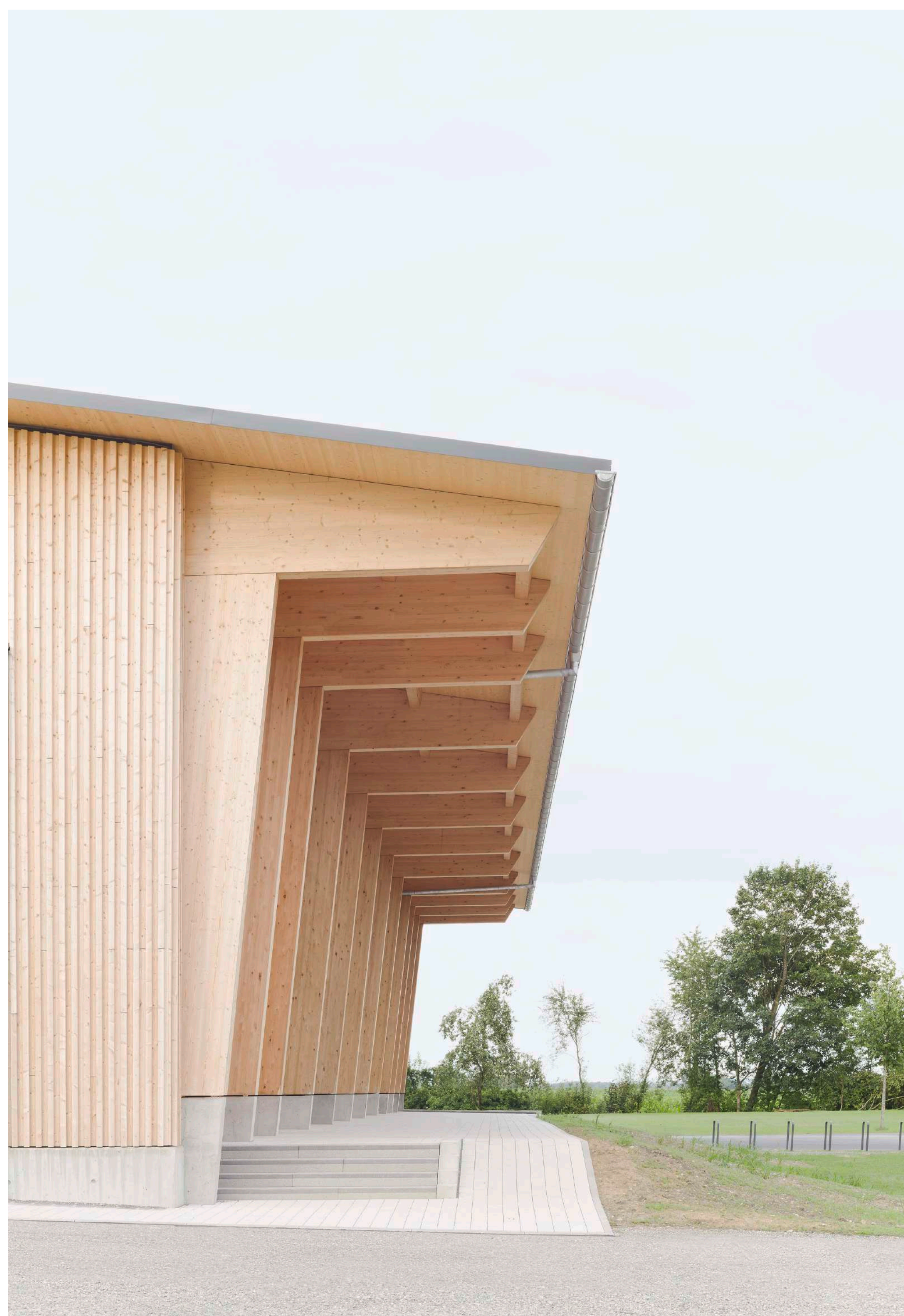
↑ ... und zeichnet mit seiner geschwungenen Unterseite den Momentenverlauf im Brettstichholzträger nach.
