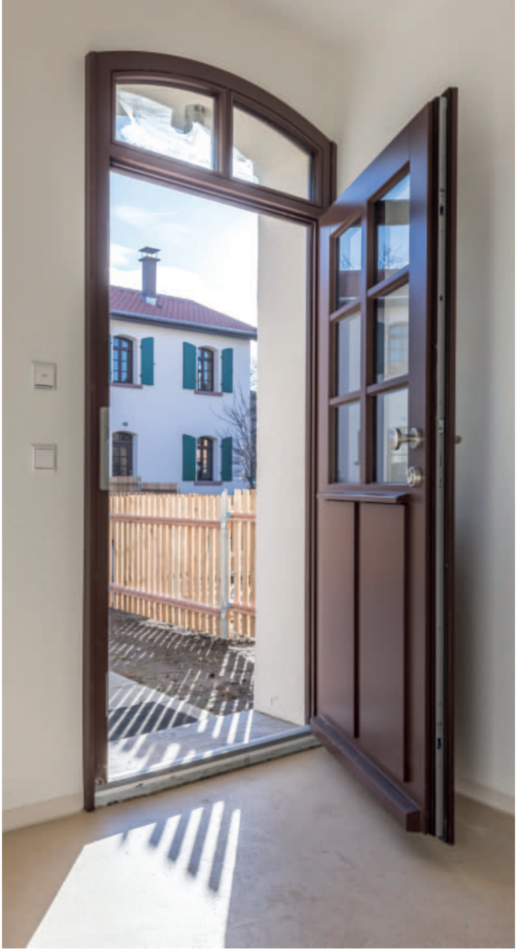
Eingangstür mit Sprossenfenster, Quelle: Spiegelhalter, FSI
