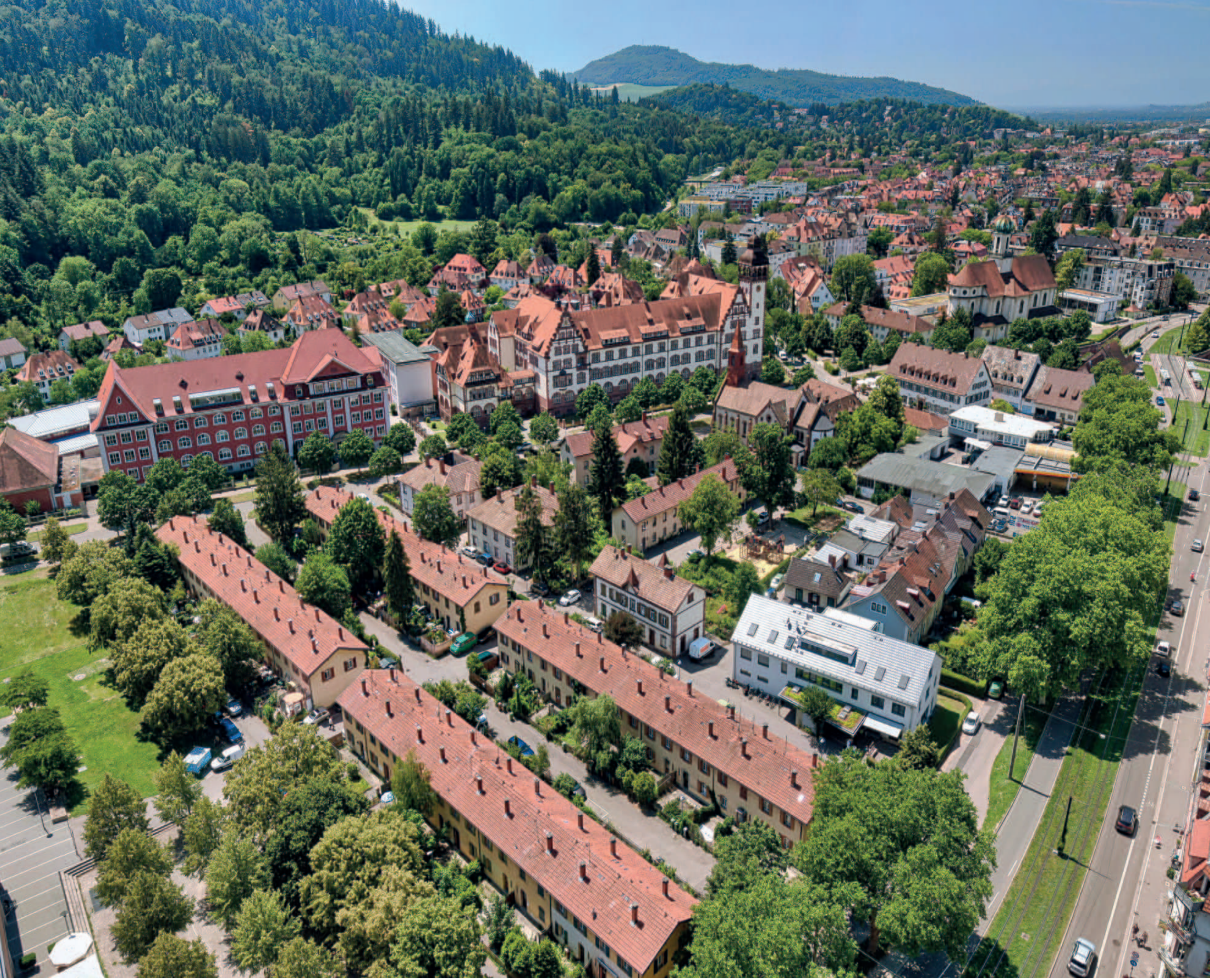
Luftbild Knopfhäusle-Siedlung, Stand vor der Sanierung, Quelle: Raiber
