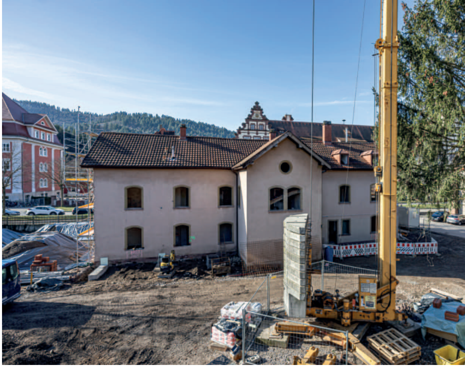
Bauarbeiten am Gebäude der ehemaligen Mädchenanstalt, Quelle: Spiegelhalter, FSI
