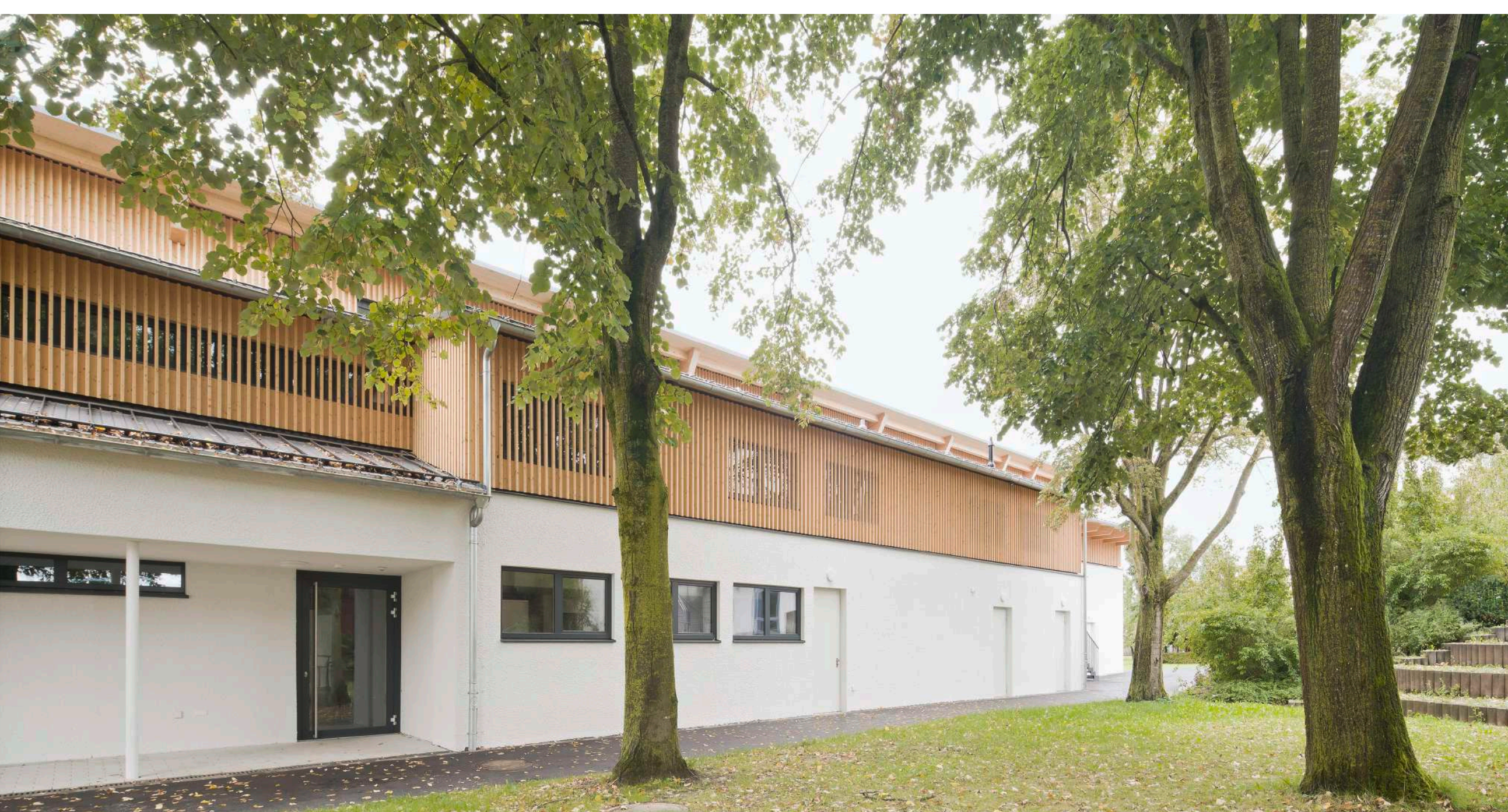
↓ Durch die hinterlüftete Holzfassade wird die Aufstockung in leichter Holzrahmenbauweise ablesbar.
