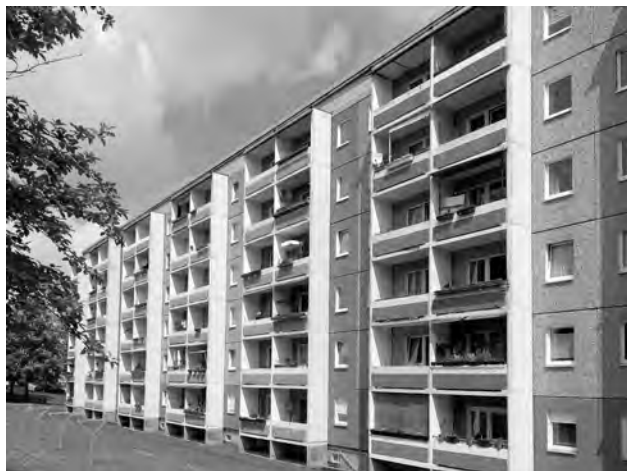
Abb. 7: Typisches Wohngebäude in Plattenbauweise vor der Sanierung.
