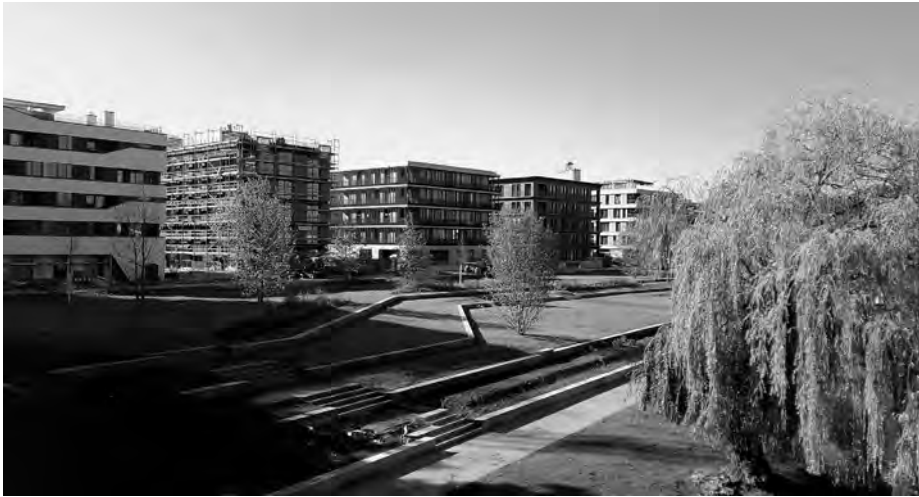
Abb. 6: Urbanes Quartier „Neckarbogen“ in Heilbronn.
