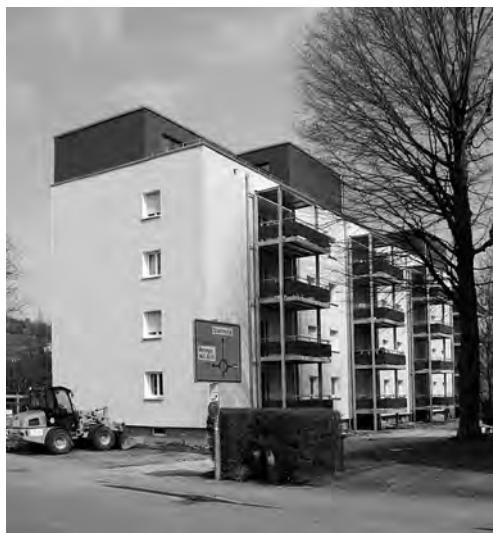
Abb. 7: Esslingen: Nachverdichtung durch Aufstockung.
