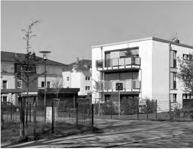
Abb. 3: Güstrow. Neuer privater Wohnungsbau „Am Schloss“; Foto: M. Bräuer, 2019.
