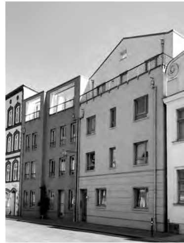
Abb. 3: Güstrow. Bestands- und Neubau in der Innenstadt; Foto: M. Bräuer, 2019.
