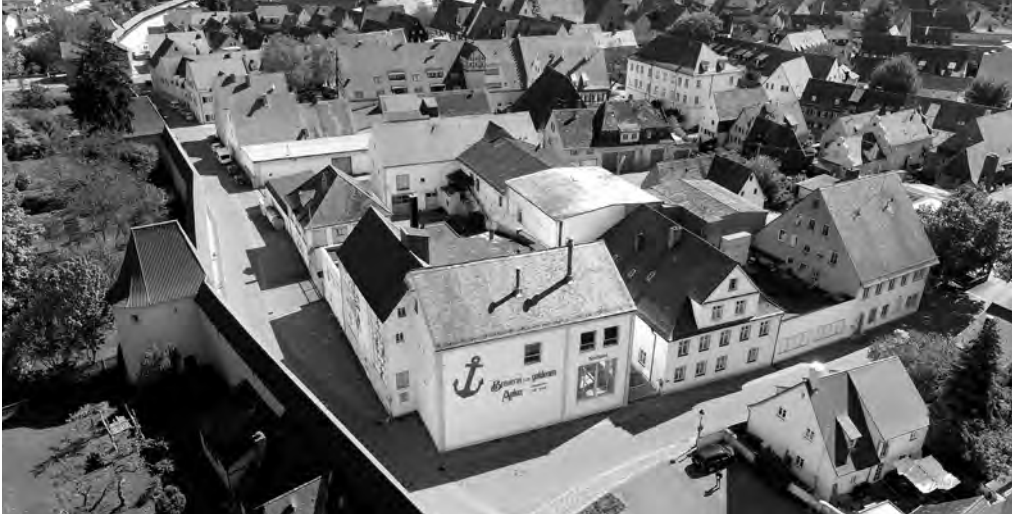
Abb. 6: Nördlingen, ehemalige „Anker-Brauerei“ innerhalb der Stadtmauer. Foto: Stadt Nördlingen.
