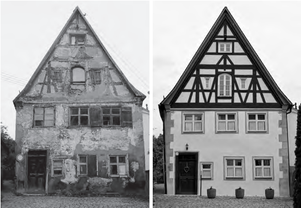
Abb. 2, 3: Nördlingen, Mühlgasse 4 vor und nach der Instandsetzung.
