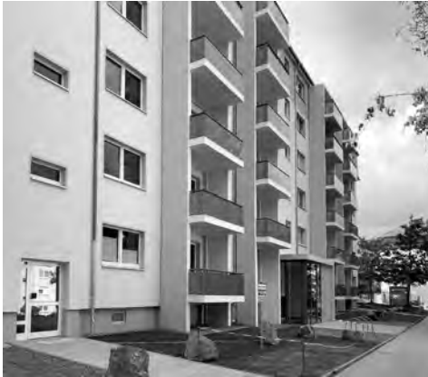
Abb. 8: Freiberg. Wohngebäude nach barrierefreiem Umbau und mit vielfältiger Wohnraumstruktur; Foto: B. Hunger.
