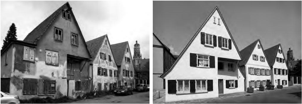
Abb. 4, 5: Nördlingen, Beck'sche Häuser 8-12 vor und nach der Instandsetzung. Fotos: Stadt Nördlingen.
