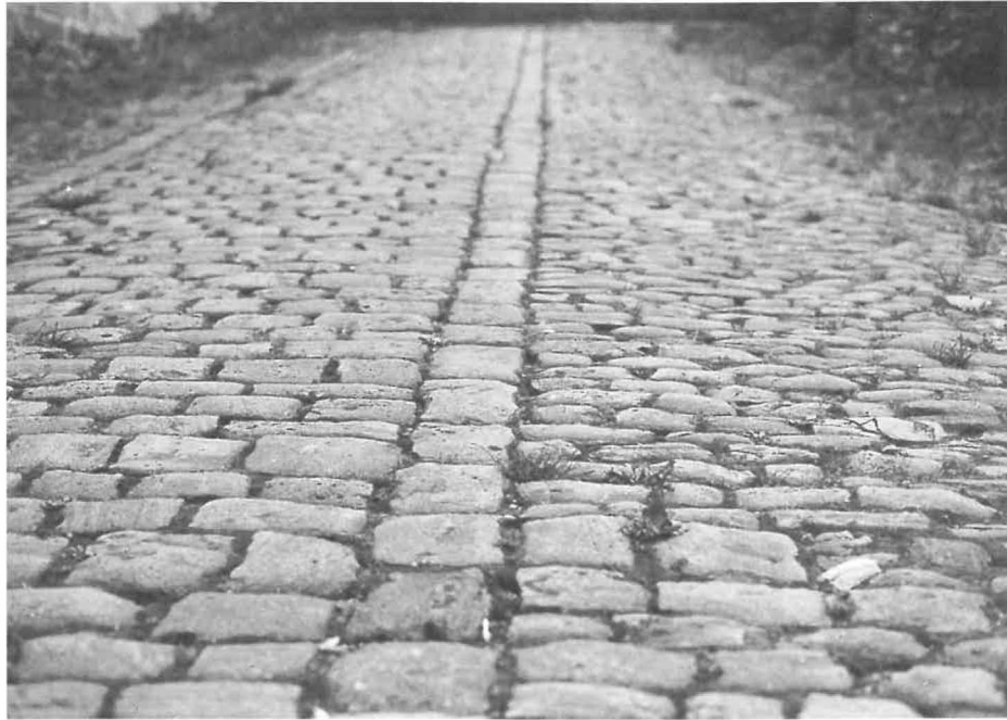
Abb. 4: Nördliche Auffahrt zur Oberen Pfarre, Detail bergaufwärts (E. Heil, 1995).
