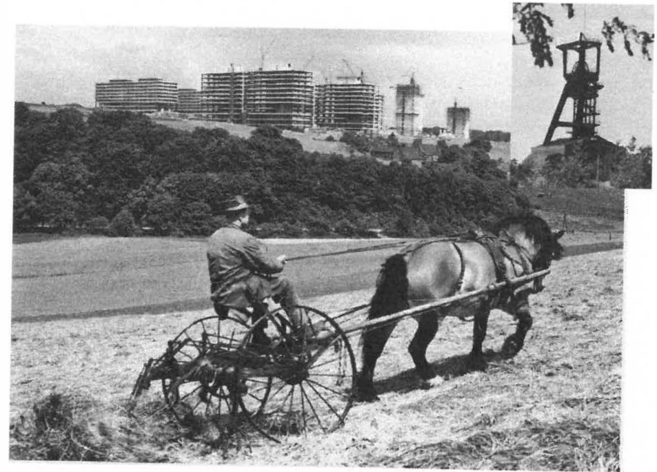
Abb. 1: 1966: Bau der Universität (Stadtarchiv Bochum); Förderturm der Zeche Holland (Planungsamt Bochum).
