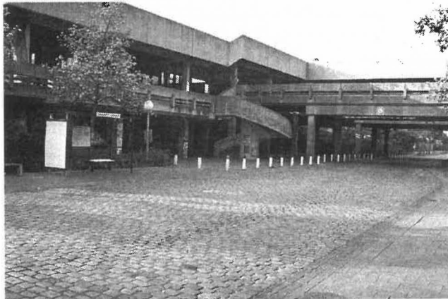
Abb. 5: Universität Bremen: Getrennte Ebenen für Straße und Fußweg im Zentralbereich.
