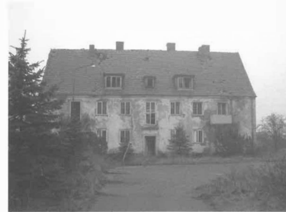
Abb. 5: Die Gebäude der Gartenstadt auf Wustrow sind stark renovierungsbedürftig. (Foto: A. Wäsch, Stuttgart).
