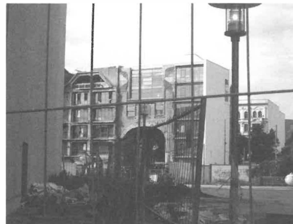
Abb. 3: Das von Fundus renovierte Tacheles-Gebäude: Der Versuch, den anarchischen Charme zu wahren (Foto: S. Schluchter).
