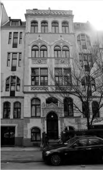
Abb. 2: Gründerzeitliches Wohngebäude in der Genter Straße; Foto: K. Zehner.
