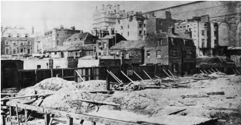
Abb. 2: Modell London: schrittweise Transformation der alten Stadt in eine Geschäftsstadt („City“). Das Bild zeigt den Bau der Uferbefestigung (Victoria Embankment) in der Nähe von Charing Cross während der 1860er Jahre. Die kleinen Bauten im Vordergrund mussten kurz darauf der Anlage einer Straße weichen; Quelle: G. Stamp (s. A 3), S. 166.
