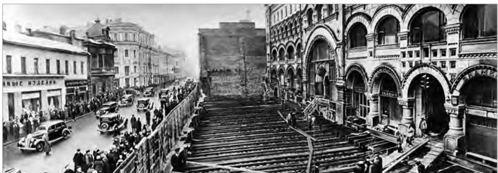
Abb. 7: Fall Moskau: Translozierung wertvoller Bauten, hier: Gebäudeverschiebung des Hauses Nr. 24 in der Gor'kijstraße, um 1940; Quelle: H. Bodenschatz/C. Post (s. A 18), S. 229.
