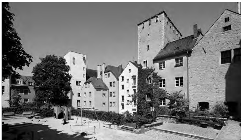
Abb. 9: Entkernter Block in der Regensburger Altstadt mit zur Schau gestellten Rückfassaden und „erfundenen“ Patriziertürmen, nördlich des Scheugässchens; Quelle: Stadt Regensburg, Peter Ferstl .
