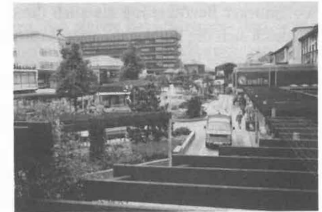
Abb. 6 Fußgängerzone im Mittelteil der Porschestraße.
