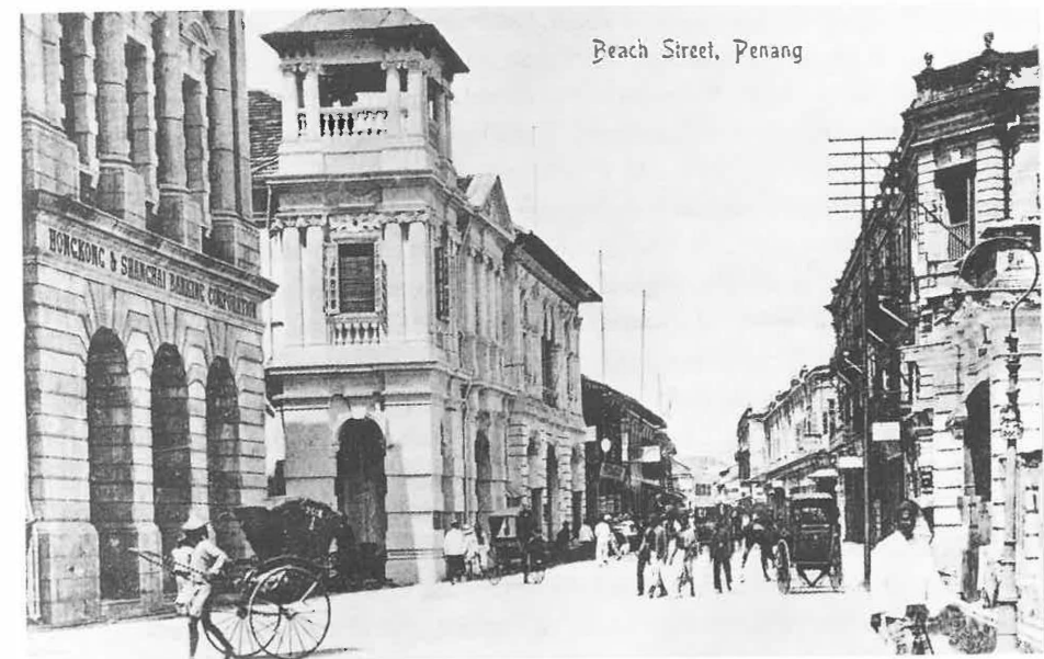
Abb. 1: Die »Beach-Street« gehört zu den ursprünglichen, im Kolonialraster angelegten Straßen und entwickelte sich im 20. Jahrhundert zum Bankenviertel. Im Hintergrund noch links und rechts der Straße die typische zweigeschossige Shophouse-Bebauung.
