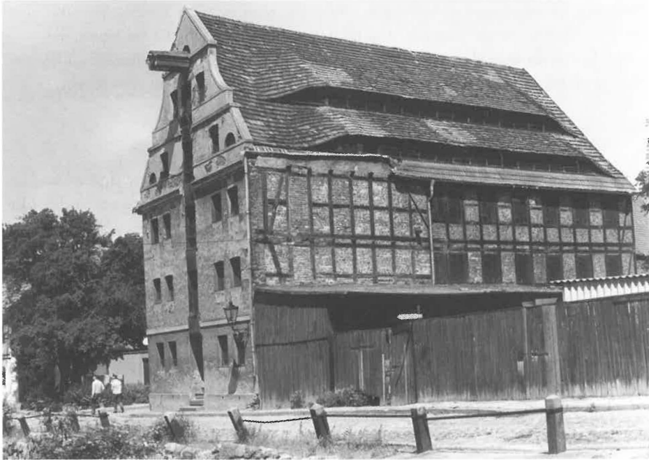
Abb. 1: Wismar, Königsspeicher an der Grube vor der Sanierung.
