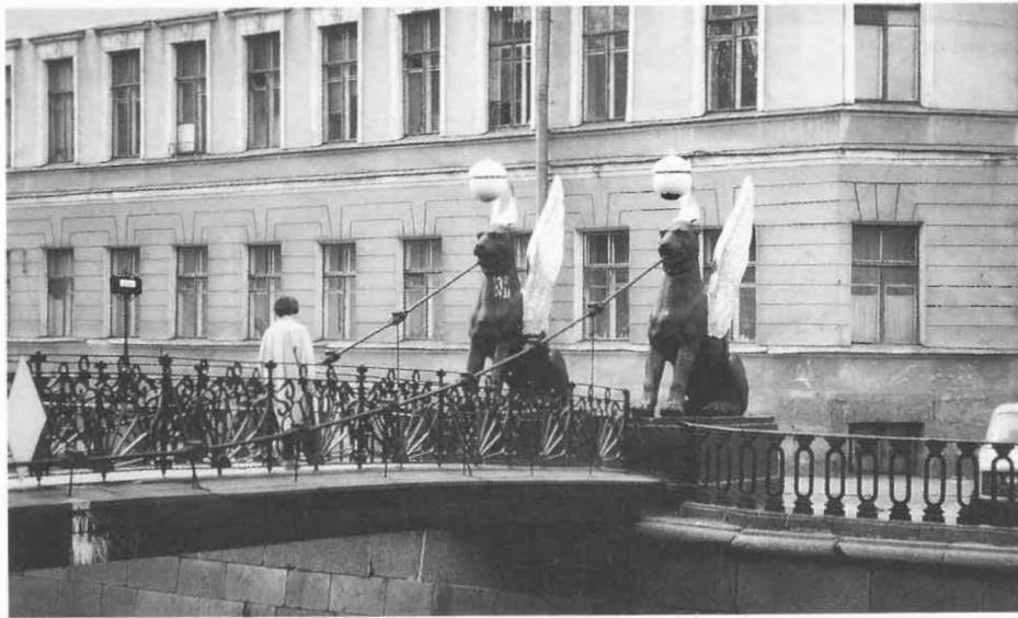
Abb. 8: Bankowski-(Greifen-)Brücke über den Gribojedow-Kanal (früher: Katharinenkanal), eine der fünf Hängebrücken, die der Ingenieur Willhelm von Traitteur 1825–26 für Petersburg konstruierte. Das Greifenmotiv ist vermutlich ein Import aus seiner badischen Heimat.
