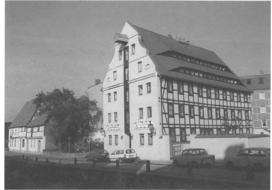
Abb. 2: Wismar, Königsspeicher an der Grube nach der Sanierung.
