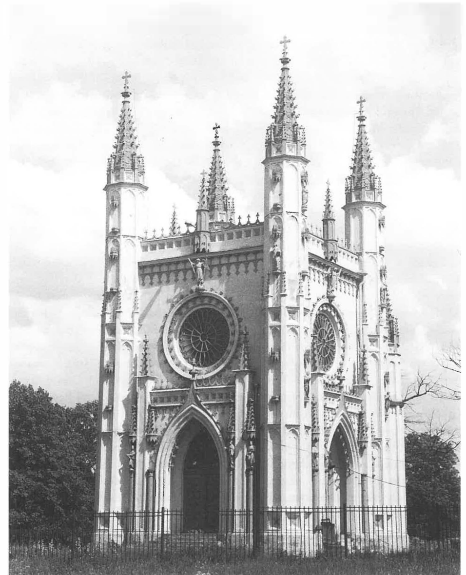
Abb. 1: Alexander-Newski-Kapelle im Schloßpark von Peterhof, Entwurf: Karl Friedrich Schinkel, 1829. Der mittelalterlich anmutende Bau verfügte im Keller über eine moderne Heizungsanlage, die den Boden der Kapelle aufwärmte und die Regenleitungen in den Ecktürmen vor dem strengen Frost schützte. Nach jahrzehntelanger Verwahrlosung des Gebäudes erfolgte jüngst eine umfassende Restaurierung, wobei einige gußeisernen Statuen in den Nischen der verputzten Mauerflächen noch fehlen (Aufnahme von 1997).
