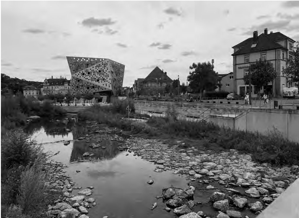
Abb. 3: Stadtumbau des Bahnhofsareals im Rahmen der Landesgartenschau 2014 in Schwäbisch Gmünd: Remstrand mit Blick auf das neu erbaute „Forum Gold und Silber“; Foto: S. Karic.
