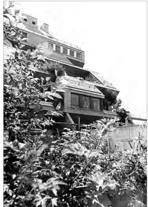
Abb. 4: Terrassenhaus „Schnitz“ 1973/74 in Stuttgart-Neugereut; Foto: T. Harlander.
