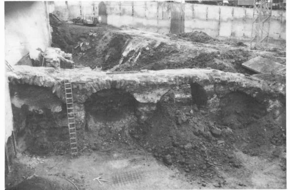
Abb. 8.18 Reste der Wallmauer der Festung Schorndorf. Baugrube Künkelinreal 1987
