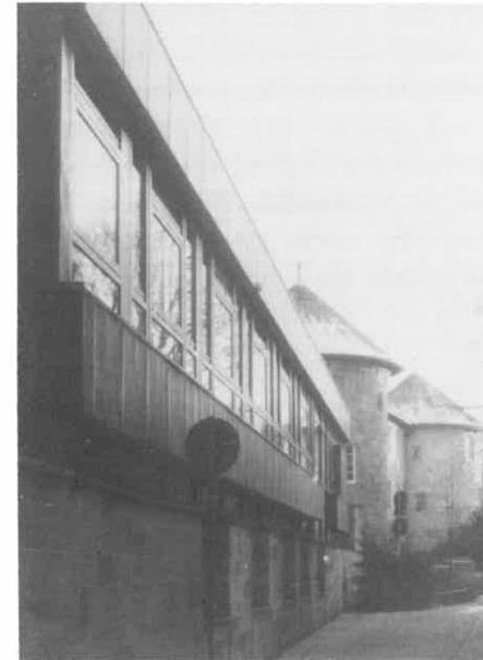
Abb. 8.8 Neubau Finanzamt vor dem Schloß Foto York Kautt
