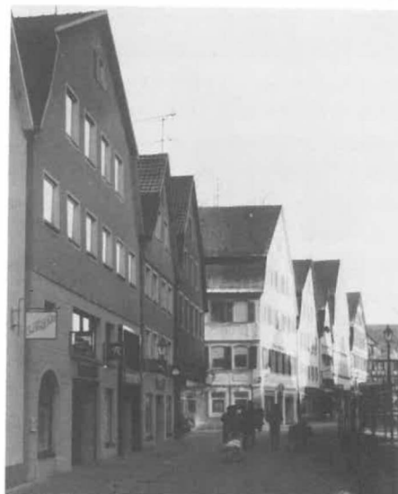
Abb. 7.7 Fluchtlinie und Mansarddächer markieren den Städtebau des 18. Jahrhunderts Fotos York Kautt
