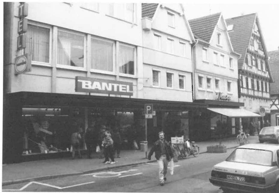
Abb. 7.1 Ablösung Obergeschosse durch Ladenausbau
