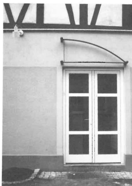
Abb. 7.3 Beispiel altstadtgerechter Materialanwendung Fotos York Kautt
