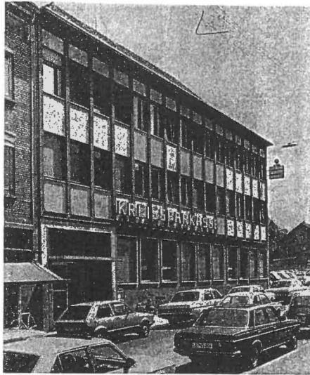
Abb. 8.12 Kreissparkasse Neubau 1957. Ansicht Schulstraße
