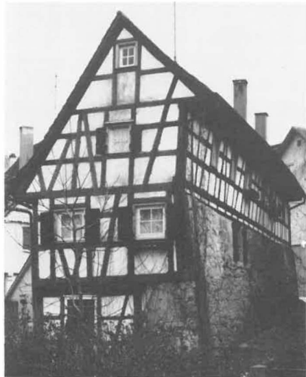
Abb. 7.5 Gebäude auf staufischer Stadtmauer mit mittelalterlichem Zuschnitt
