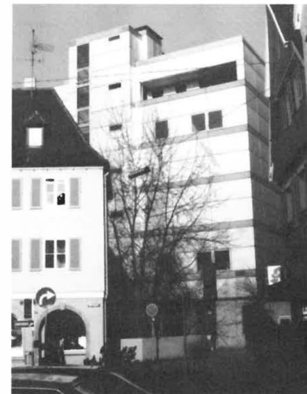
Abb. 8.3 Fernmeldegebäude nach dem Umbau Foto York Kautt
