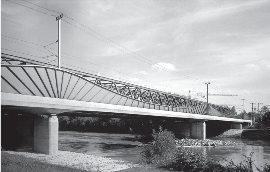
Abb. 3: Ingolstadt: Donaubrücke der Bahn (2001).
