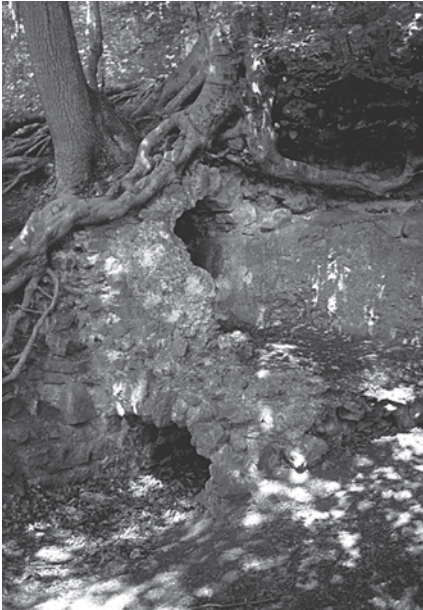
Abb. 3: Durchlass unter der Eifelwasserleitung bei Urft-Dalbenden.
