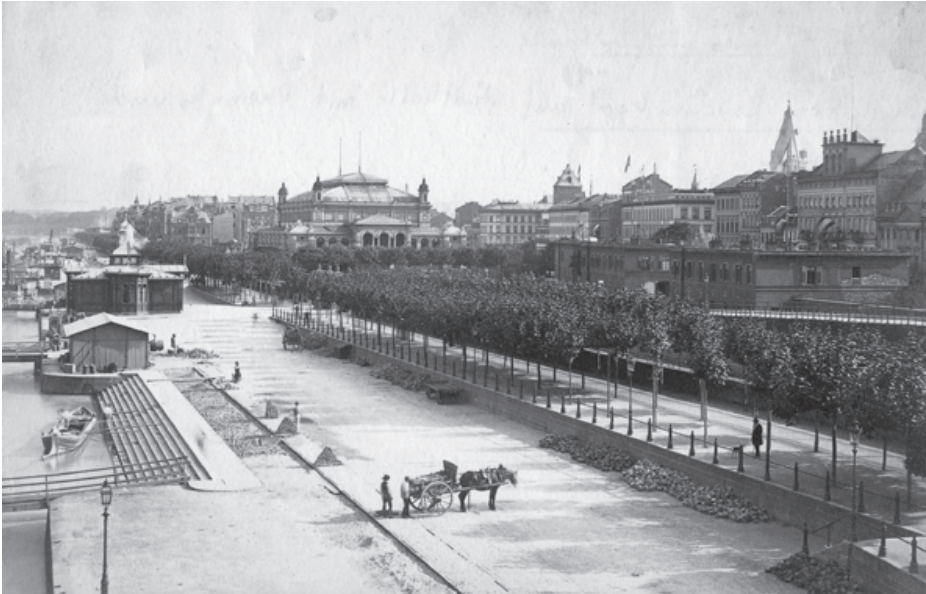
Abb. 2: Foto um 1890. Die nunmehr auf Grund der Rheinregulierung befestigte Uferzone gliedert sich in eine untere Ebene mit überwiegend schiffahrtsbezogener Nutzung und abschnittsweise mit Treppen zum Wasser hin ausgestattet, sowie eine obere Ebene, die als baumbestandene Allee ausgebildet war ( Stadtarchiv Mainz ).
