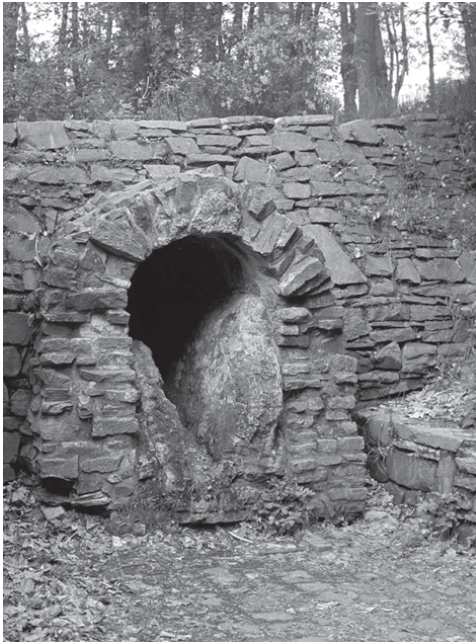
Abb. 2: Eifelwasserleitung bei Kreuzweingarten.
