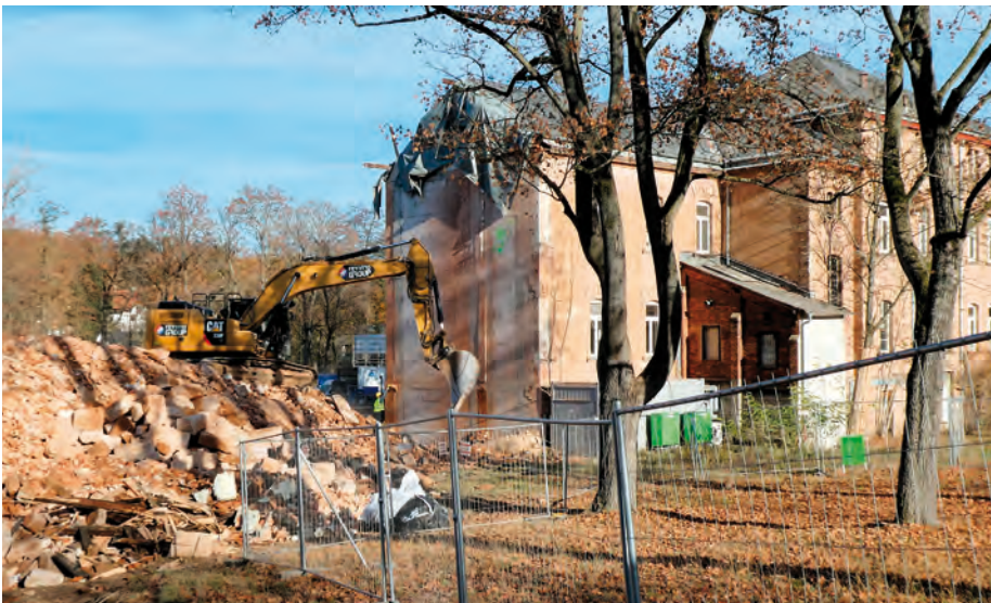
Abb. 4: Heil- und Pflegeanstalt (,Hupfla'), Erlangen. Abriss der Seitenflügel.
