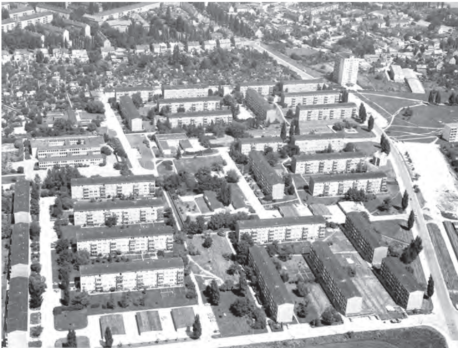
Abb. 7: Eines der Objekte der Beispielliste für die Aufnahme von »Denkmalen der Geschichte der DDR« (Kreises Merseburg) von 1980: der Wohnkomplex Am Gradierwerk in Bad Dürrenberg (1959-61). Der Eintrag lautet: »Musterkomplex der Bauakademie der DDR als Vorbild für die Serienfertigung im Wohnungsbau der DDR in Großblockbauweise«; Quelle: Leibniz-Institut IRS Erkner.
