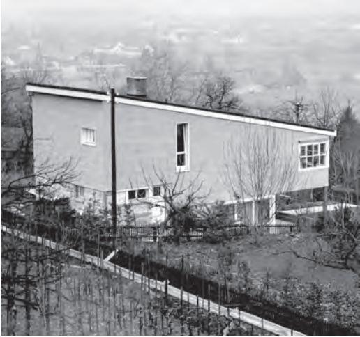
Abb. 1: Max Alioth, Einfamilienhaus in Reinach (Kanton Basel-Land), 1961; aus: Werk 1964, H. 5, S. 175.
