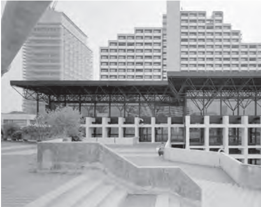
Abb. 1: München, Olympiazentrum, alte Mensa, Außenansicht nach der behutsamen Restaurierung durch Muck Petzet Architekten; Quelle: ©mp-a.
