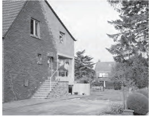
Abb. 4: Umbau nach dem Additionsprinzip: Wohnhaus Schreber, Aachen, AMUNT Architekten, Martenson und Nagel Theissen; Quelle: ©RRR, E. Overmeer 2012.
