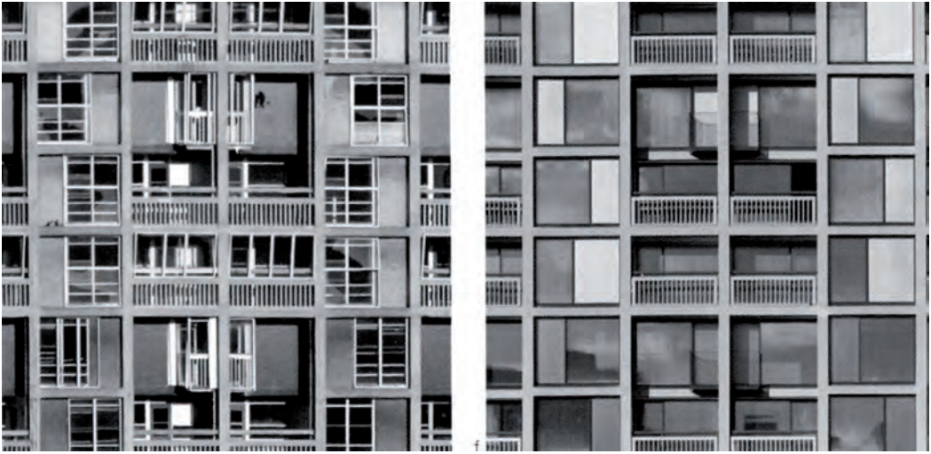
Abb. 8: Details Fassadengestaltung Park Hill in Sheffield, Vergleich Ursprungszustand und Zustand nach der Sanierung durch Urban Splash mit Hawkins/Brown und Studio Egret 2013; aus: N.N. , Sanierung der Siedlung Park Hill in Sheffield, in: Detail 4 (2013), S. 371.
