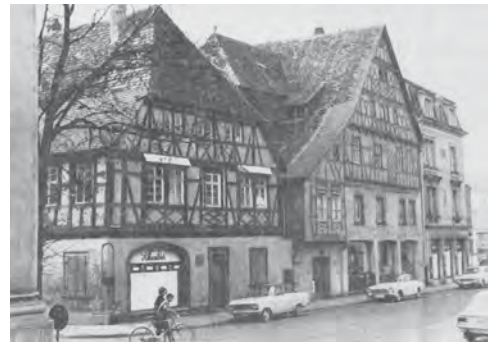
Abb. 4: Zum Abbruch vorgesehene Fachwerkhäuser bei der Martinskirche; Aufnahme: M. Karg, 1969; Quelle: Badische Neueste Nachrichten, 14.02.1969.
