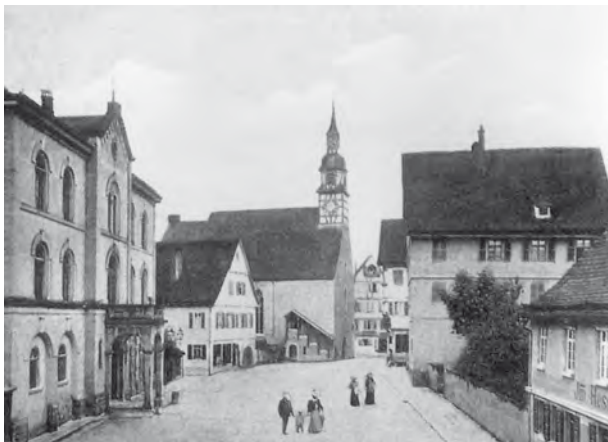
Abb. 8: Neuer »Rathausplatz« mit dem 1875 auf dem ehemaligen Schlossgelände neu erbauten Rathaus (li.) sowie dem Oberamtsgebäude, der Buchhandlung Hess und dem dazwischenliegenden Garten (re.), an deren Stelle das spätere Marktdreieck errichtet wurde; Quelle: Stadtarchiv Waiblingen .
