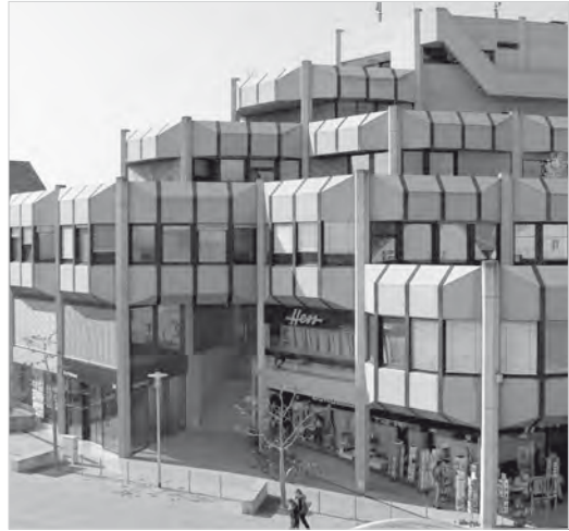
Abb. 26: Treppensituation Marktdreieck nach der Sanierung; Foto: H. Schultheiß, 2013.
