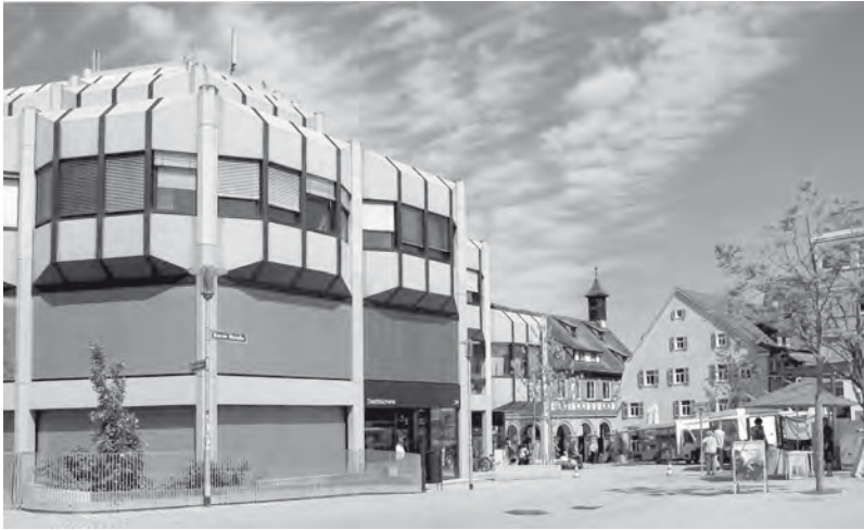
Abb. 27: Fassadenveränderungen am Marktdreieck (Südwestseite) nach der Sanierung; Foto: H. Schultheiß, 2013.
