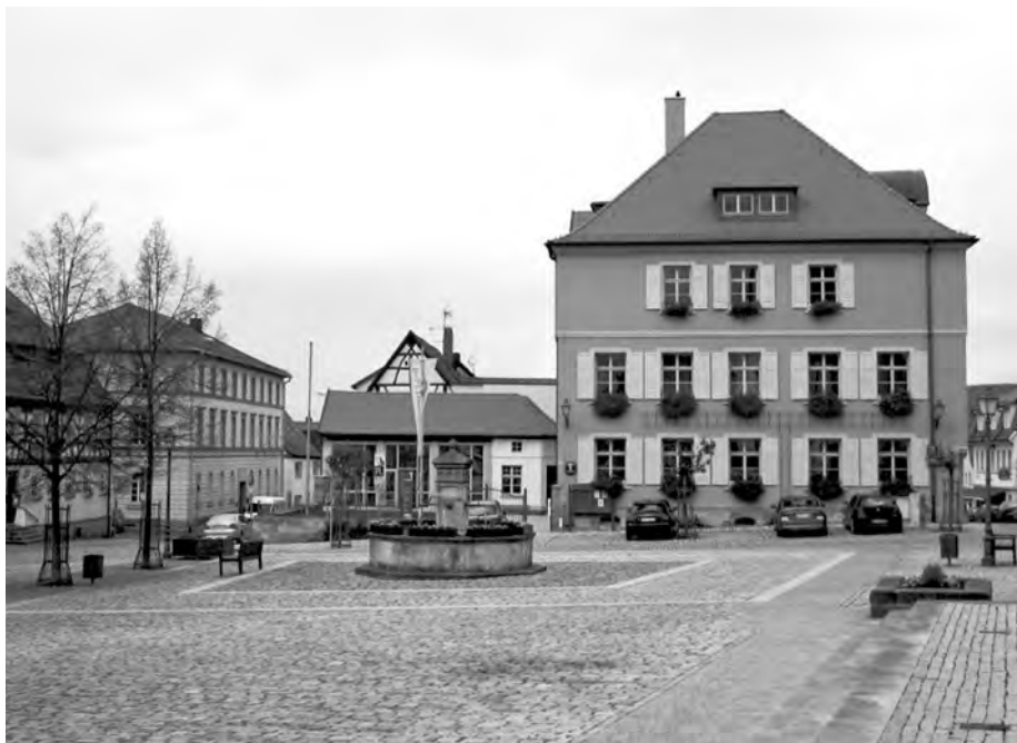
Abb. 5: Das Interkommunale Allianzzentrum fand nach Um- und Ausbau des früheren Finanzamts, unterstützt mit Städtebauförderungsmitteln, Platz am Marktplatz von Hofheim, Lkr. Hassberge; Foto: Hofheimer Allianz .
