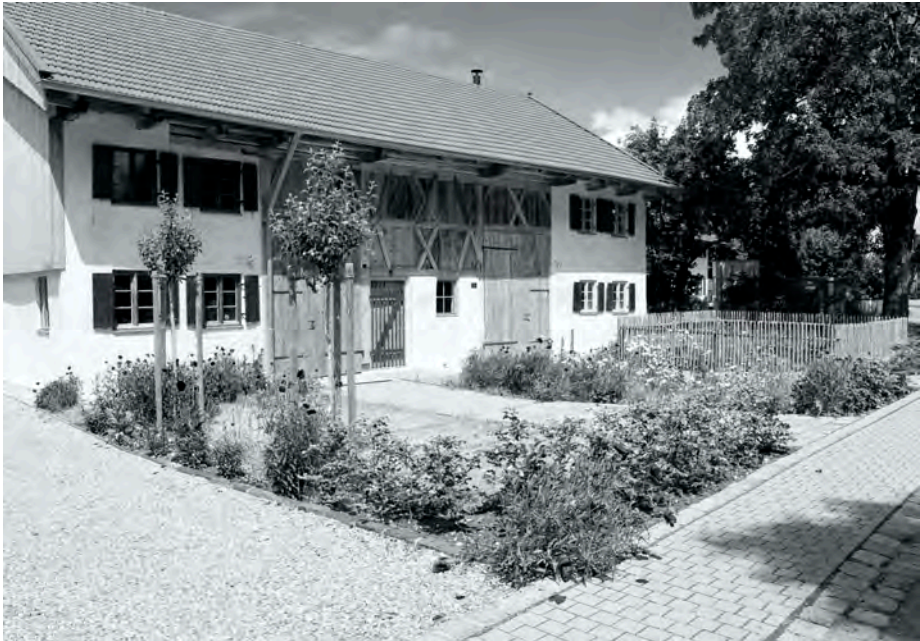
Abb. 3: Rochlhaus in Thaining. Der Erhalt des denkmalgeschützten Mittertennhauses wäre ohne das außerordentlich hohe bürgerliche Engagement vor Ort nicht möglich gewesen. Foto: Förderverein Rochlhaus Thaining e. V.
