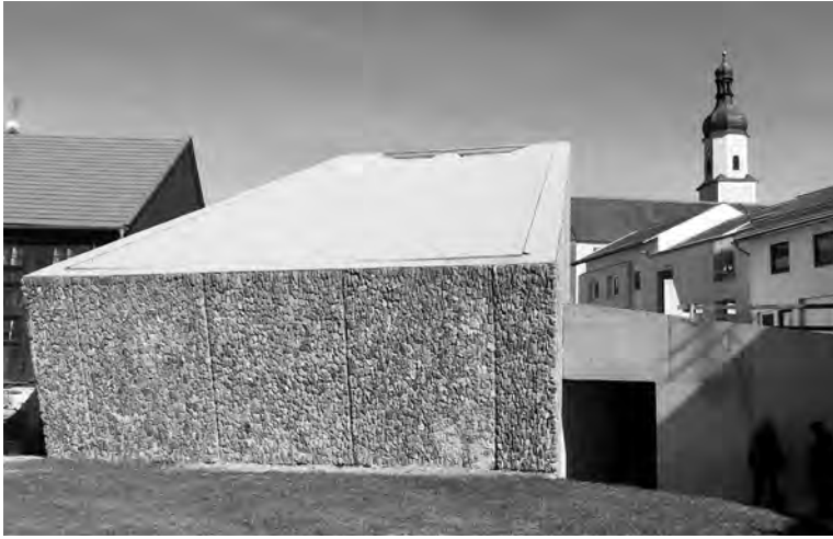
Abb. 2: Das Konzerthaus in Blaibach, Lkr. Cham (Architekt: Peter Haimerl, München) ist mit dem Bürgerhaus das bekannteste Vorhaben von Ort schafft Mitte zur Beseitigung von Leerständen und Revitalisierung von Ortskernen im ländlichen Raum; Ansicht von Süden mit dem barrierefreien Zugang; Foto: Armin Keller.
