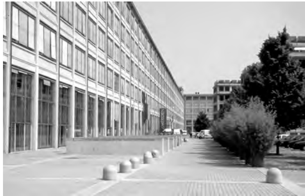
Abb. 3: Der dem Shopping und anderen Zwecken dienende Kultbau „Fiat Lingotto“ - Kern eines neuen, erwünschten Zentrums im Süden der Stadt (Foto: H. Bodenschatz, 2006).
