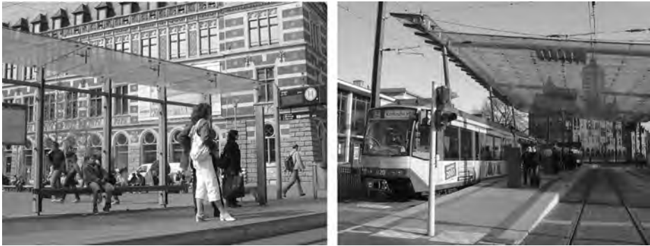
Abb. 7: Fahrgastunterstände am Anger in Erfurt (li.) und Überdachung des Bahnhofsvorplatzes in Heilbronn (re.; Fotos: H. Topp).
