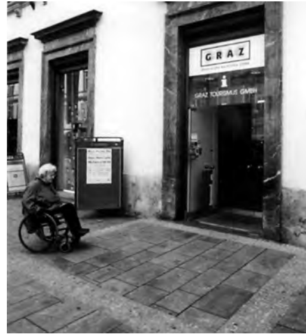
Abb. 3: Gehweganhebung als „Rampe“ für Rollstuhlfahrer und Orientierung für Blinde, aus: G. Hohenester / A.M. Linhart-Eicher (s. A 6).
