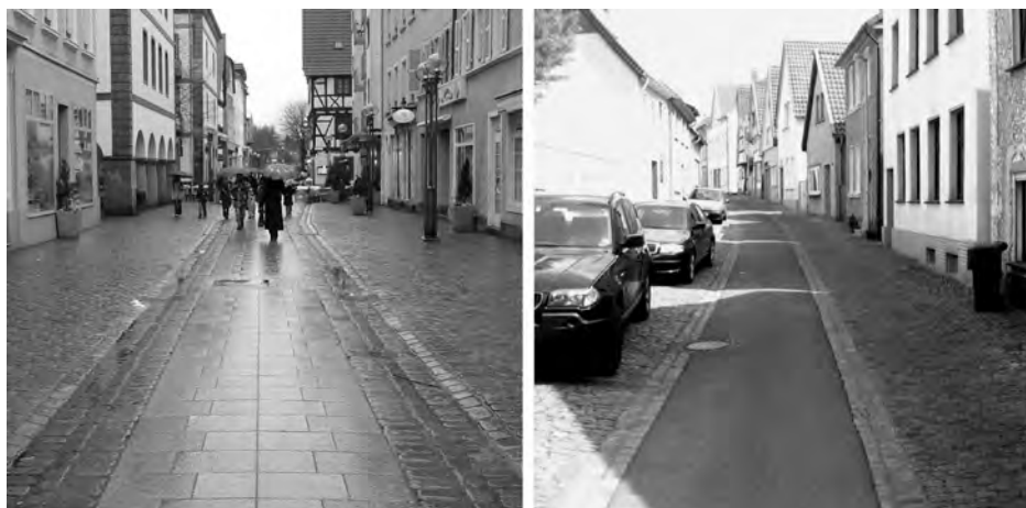
Abb. 1: Ebene Gehstreifen für Gehbehinderte und Rollstuhlfahrer geben Orientierung für Blinde und Sehbehinderte; links Landau/Pfalz (Foto: H. Topp), rechts Lemgo (Foto: Stadt Lemgo).
