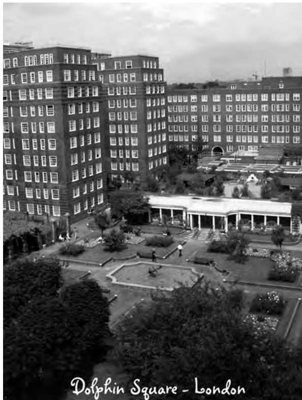
Abb. 6: Blick in den Innenhof, rückwärtig der Hotelbereich; Postkarte Dolphin Square.
