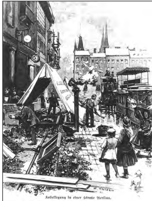
Abb. 1: Kabellegung in einer Straße Berlins, (aus: Gartenlaube 1890, S. 381).
