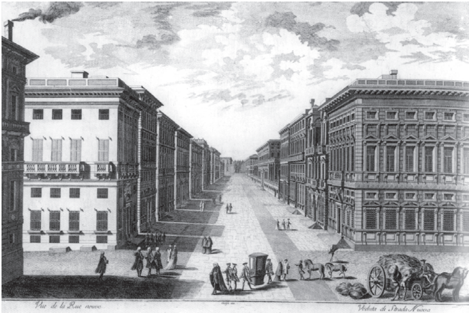
Abb. 3: Strada Nuova von Osten, 1769. Die Straße wurde auf der Ansicht breiter dargestellt als sie ist. Sie präsentiert sich noch als Stichstraße, ein Zustand, der erst mit dem Bau der Strada Novissima (um 1780) überwunden wurde; Quelle: E. Poggi (s. A 12), S. 54.
