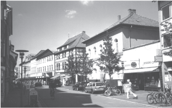
Abb. 4: Die Ostseite der Kurzen Geismarstraße 2002. Rechts neben dem ehemaligen Pächterwohnhaus Nr. 22 an Stelle der ehemaligen Hofeinfahrt das eingeschossige Ladengeschäft Nr. 20.
