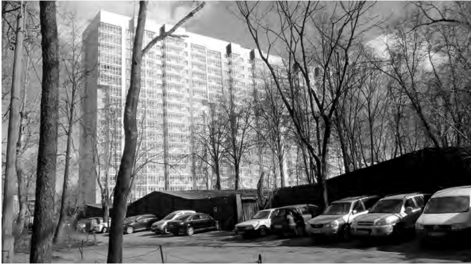
Abb. 8: Neue Wohnscheibe Umsiedler des Chruščevka-Programms.
