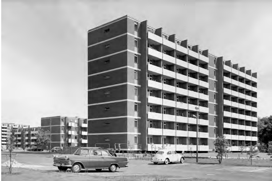
Abb. 5: Einheitliche Gestaltungselemente und Orthogonalität der Fassaden.
