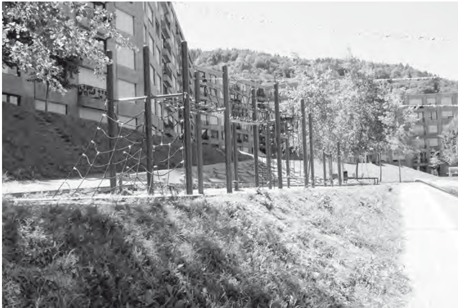
Abb. 3: Grüne Böschungen, Spielbereiche und Pappeln in der Triemli-Siedlung in Zürich;
