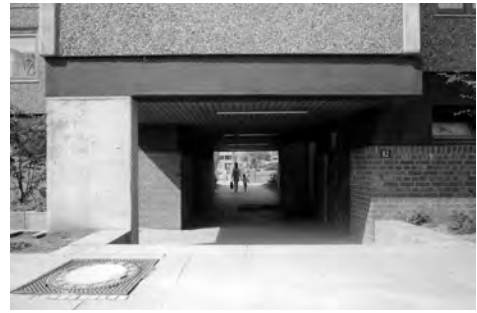
Abb. 6: Durchgang von der Straße zum Innenhof, 1973.
