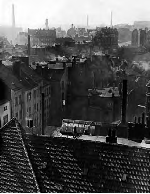
Abb. 1: Fotografie des Sanierungsgebietes Altona-Altstadt, 1958.
