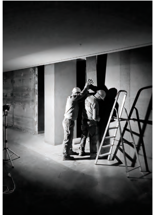
Abb. 4: Ein Team von Rotor DC demontiert die Wandverkleidung aus italienischem Granit in den Führungsetagen der Générale de Banque, 2015. Die Innenräume der Bank wurden von Jules Wabbes entworfen; Quelle: Rotor.
