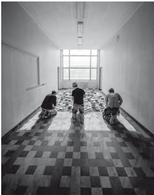
Abb. 6: Fliesen aus den 1930er Jahren werden von einem Rotor DC-Team in der ehemaligen Ingenieurschule der Universität Lüttich (Sart Tilman) ausgebaut, 2014; Quelle: Olivier Béart .
