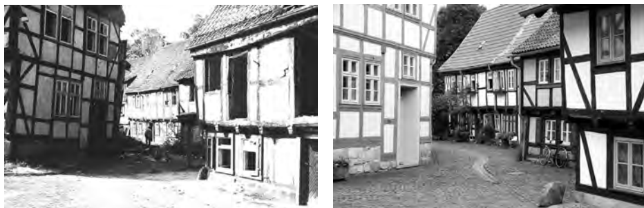
Abb. 3: Halberstadt; Gebäude im historischen Kern erwachen aus dem Dornröschenschlaf und tragen entscheidend zur Identität des Ortes bei.
