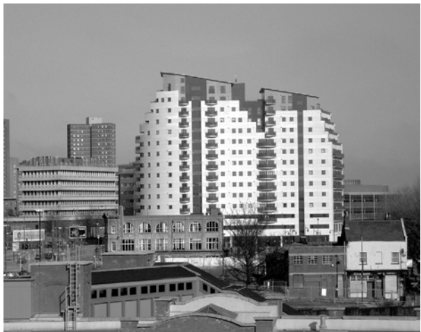
Abb. 6: Neuer Hochhausblock (der erste von 12 geplanten) mit Apartment-Wohnungen in der „East Side Regeneration Area“ von Birmingham (Foto: P.J. Larkham, 2007).
