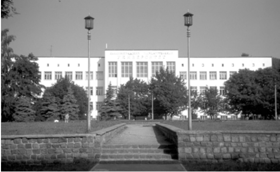
Abb. 2: Das wiederaufgebaute Hauptgebäude der Albertina, heute nach Immanuel Kant benannte Staatsuniversität Kaliningrad (Fotos: B. Hofmeister).
