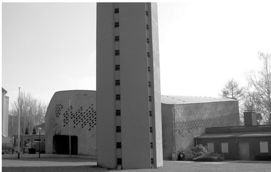
Abb. 2: Die Heilig Kreuz Kirche in Düsseldorf-Raht steht in einer sehr heterogen bebauten Umgebung an einer stark befahrenen Straße; Architekt: Josef Lehmbrock (Foto: Inst. für Denkmalschutz und Denkmalpflege, Landeshauptstadt Düsseldorf).
