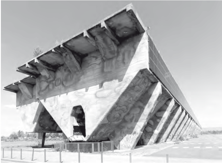
Abb. 4: Ehemaliger Kohlebunker als Solaranlage;
