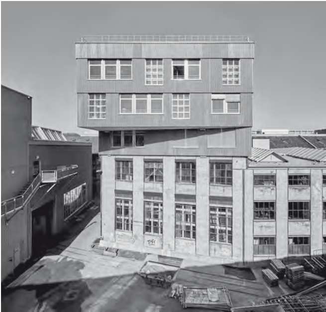
Abb. 3: Aufstockung aus gebrauchten Bauteilen: „K118“, Basel;
