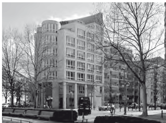
Abb. 6.2: Wohn- und Geschäftshaus von Carlo Aymonino; Quelle: Achim Raschka / CC-BY-SA-4.0.
